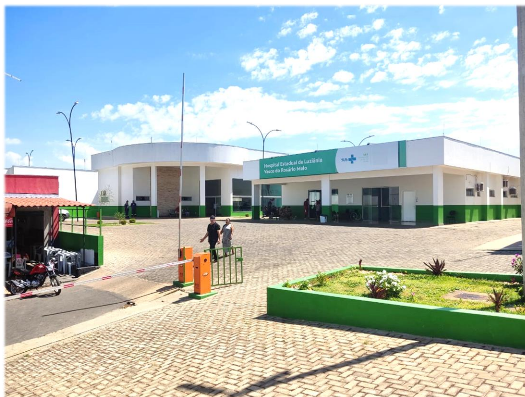
Figura 2. Fachada frontal atual
