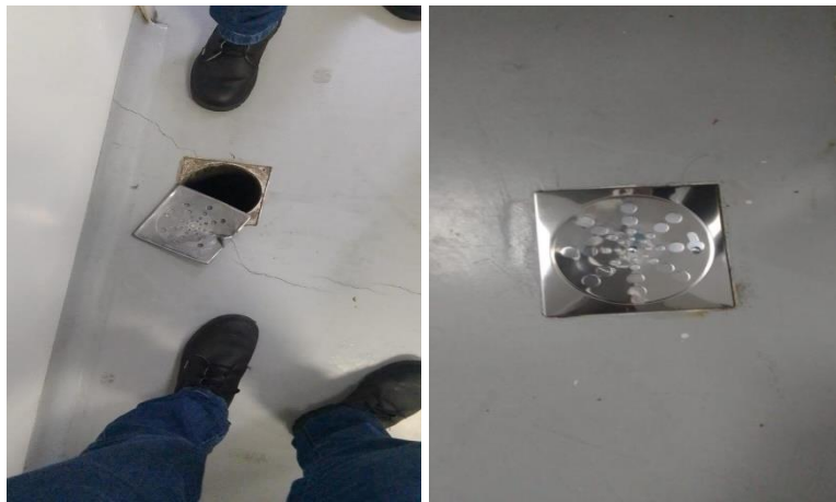
Substituição de ralo
