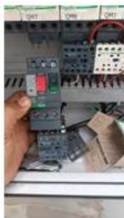
substituição de contatora e disjuntor motor
