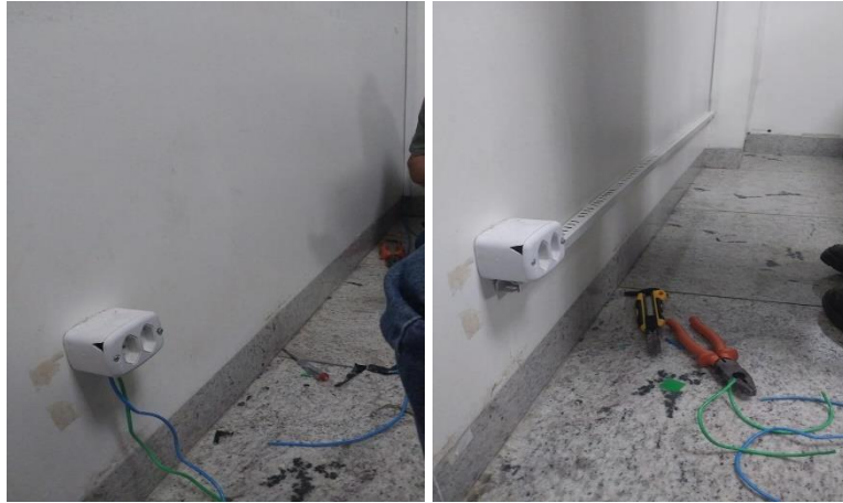
Adequação elétrica NIR.
