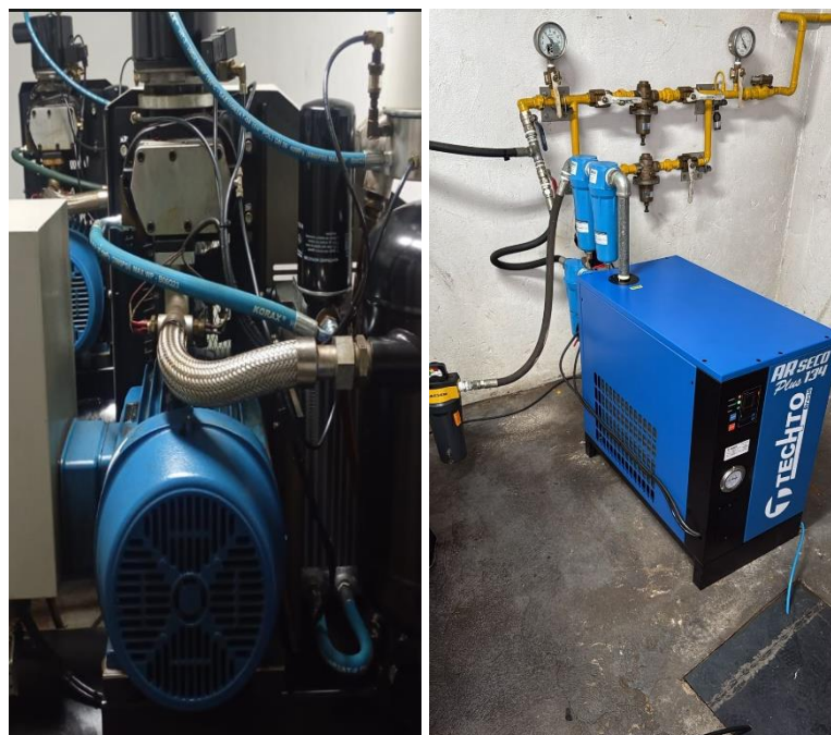
Sistema de Ar comprimido após a substituição
