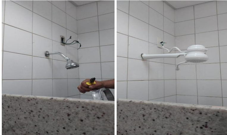
Substituição de ducha por chuveiro
