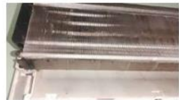
foi realizado a higienização química do equipamento , fazendo toda a remoção de fuligem.
