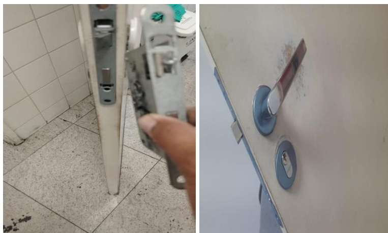
Substituição de fechaduras.
