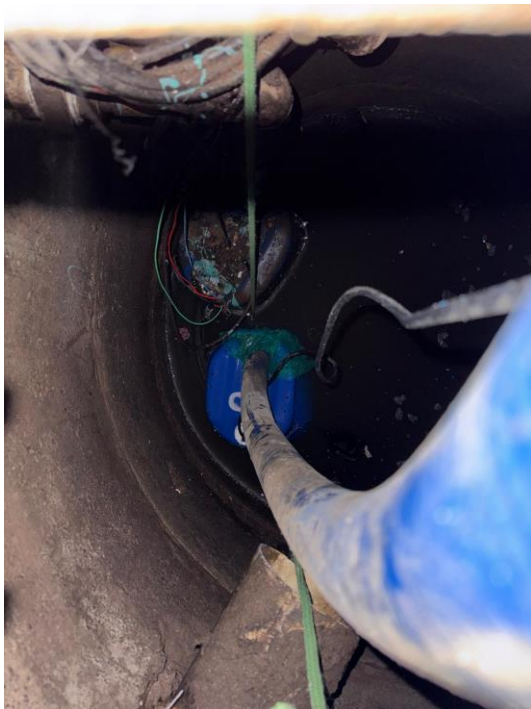
Depois: bomba substituída
