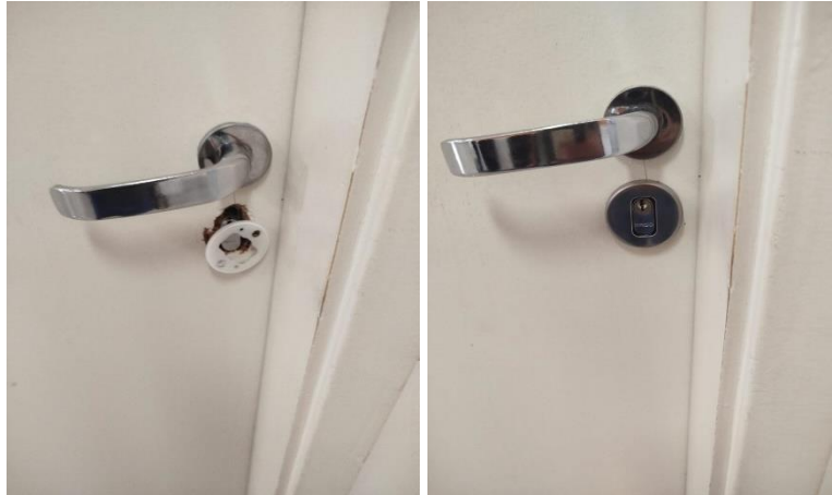
Substituição de fechadura.
