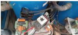
foi realizado a limpeza de contato dos bornes só compressor.
