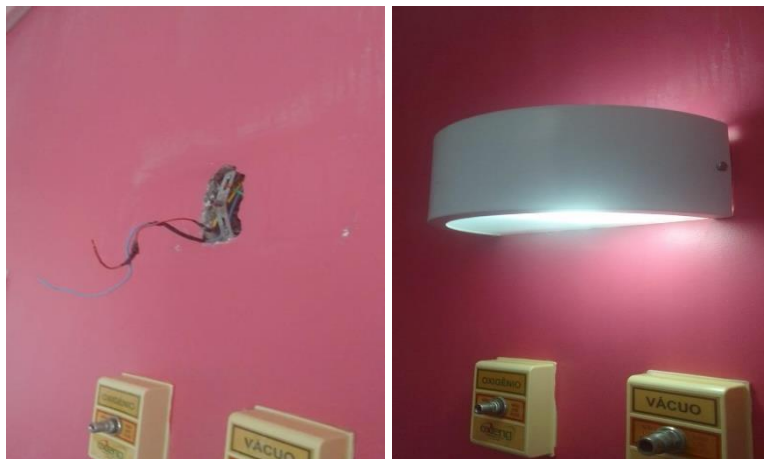
Reparo em luminária Espaço Rosa.
