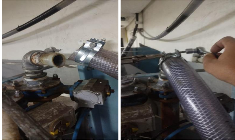
Reparo em conexão máquina de lavar.
