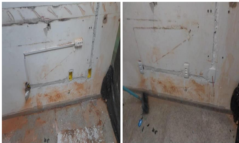
Readequação de pontos de energia e rede para CME.
