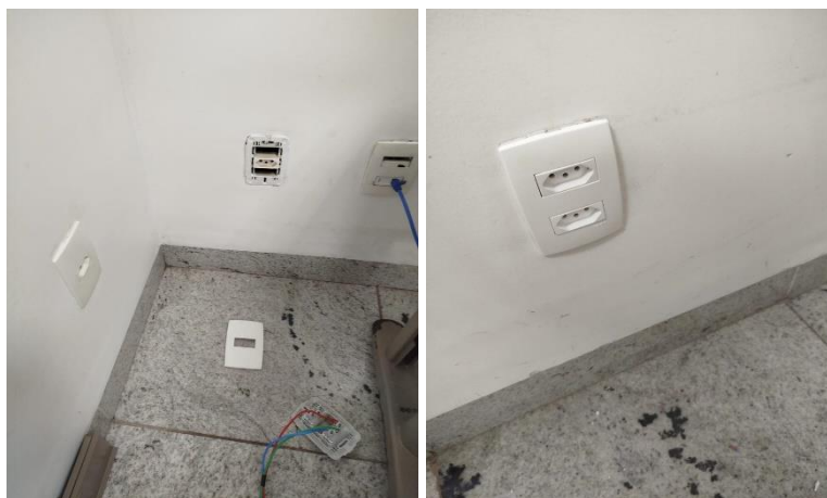
Substituição tomada simples 10A por dupla.
