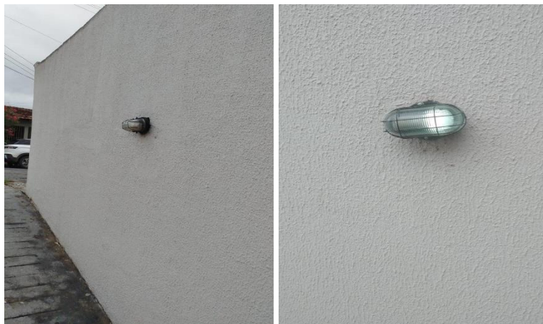
Substituição de lâmpada queimada acesso a rampa subsolo.
