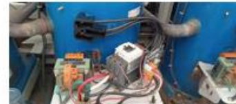
Foi realizado a troca de cabos de força do compressor 02 circuito A compressor 02
