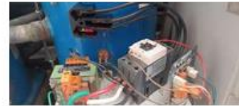
Foi realizado a troca de cabos de força do compressor 02 circuito A compressor 02
