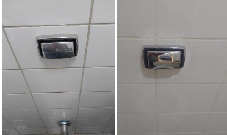
Depois: Substituição de acabamentos de descarga.
