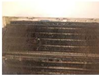
equipamento muito obstruído , impedindo o rendimento do equipamento
