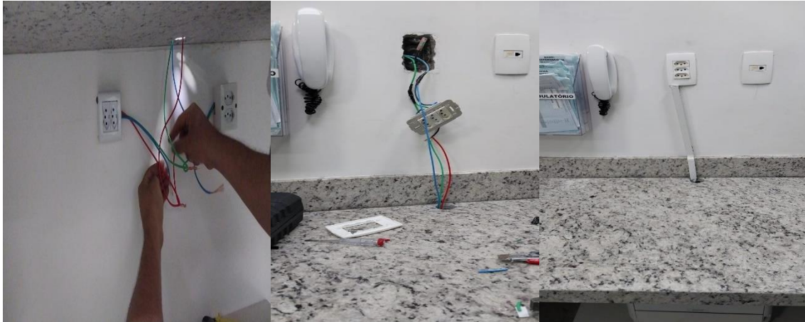
Readequação de pontos de energia.
