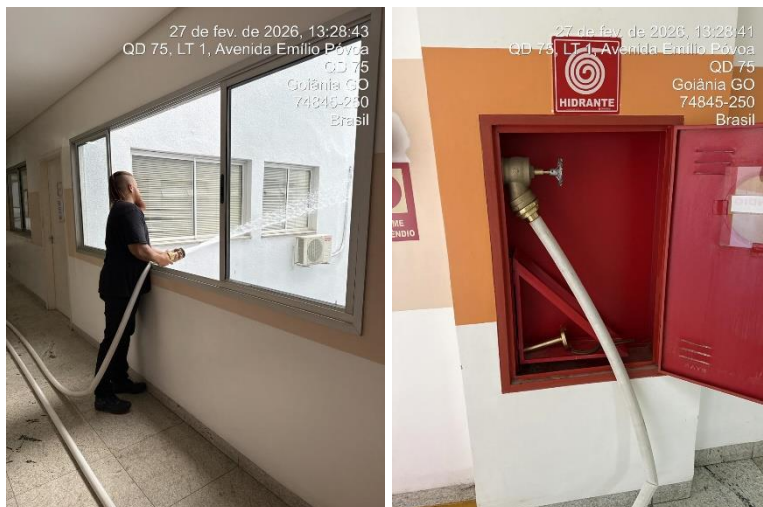
Teste da rede pressurizada.
