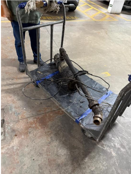
Substituição de bomba danificada e readequação de quadro.
