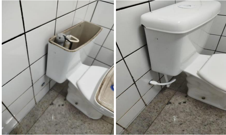
Substituição de engate e kit caixa acoplada.
