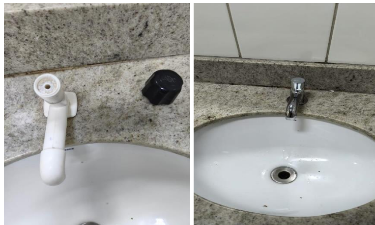
Substituição de torneira
