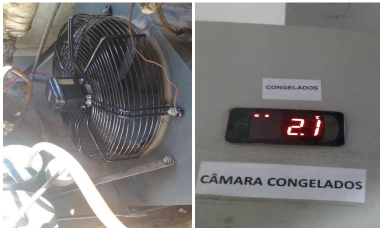
Depois: Substituição de moto ventilador câmara fria.
