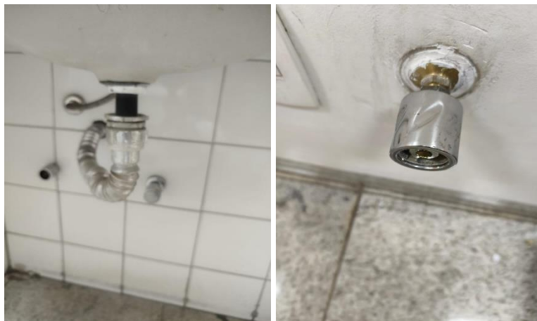
Antes: Reparo registro e sifão.
