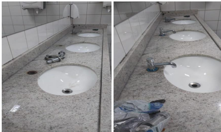
Substituição de torneiras banheiro comum térreo
