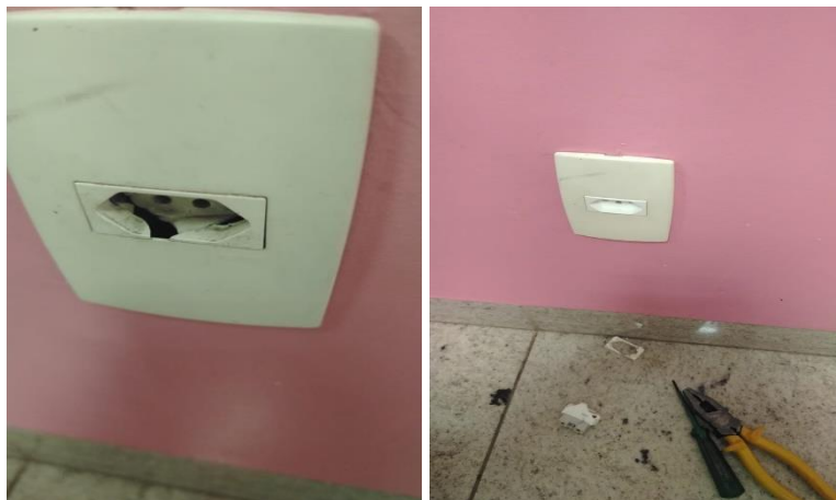
Substituição de tomada.
