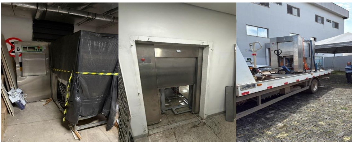
Substituição da Autoclave “B”.
