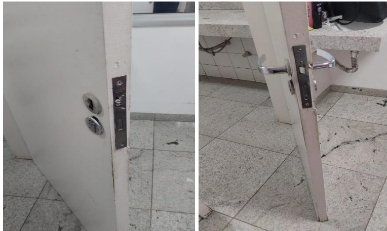
Substituição fechadura.
