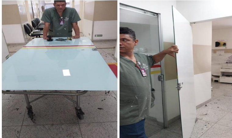
Remoção de porta para melhor fluxo nos consultórios 1 a 4.
