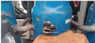
foi realizado a limpeza de contato dos bornes só compressor.
