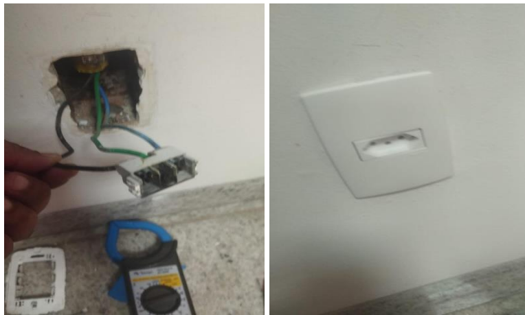
Substituição de tomada.
