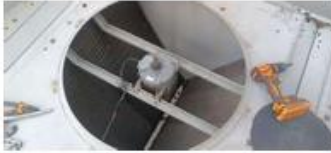
foi realizado a instalação dos motores ventiladores circuito A motor 01
