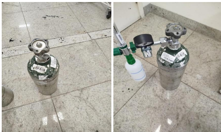
Substituição de cilindros de Oxigênio.
