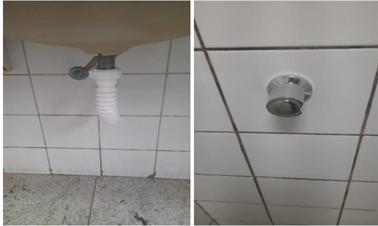
Depois: Reparo registro e sifão.
