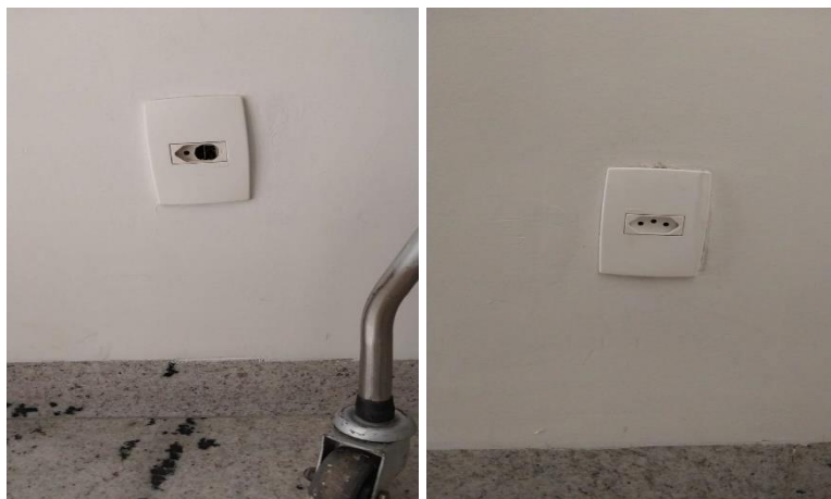
Substituição de tomada.
