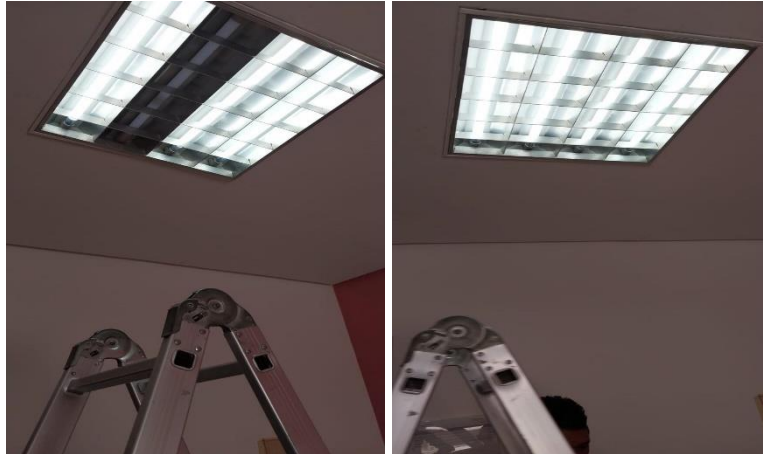
Substituição de lâmpada queimada.
