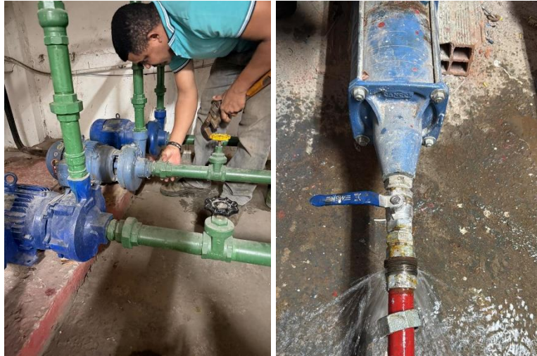
Antes: Retirada de bomba jockey e bomba elétrica.
