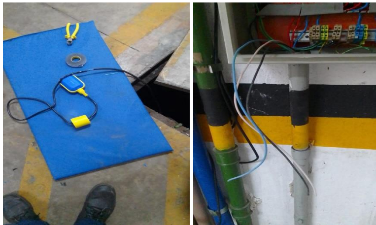
Instalação de bomba elétrica para automação de circuito pluvial.
