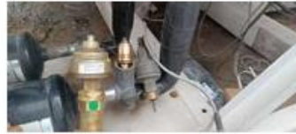
foi realizado a substituição da válvula de expansão eletrônica,
