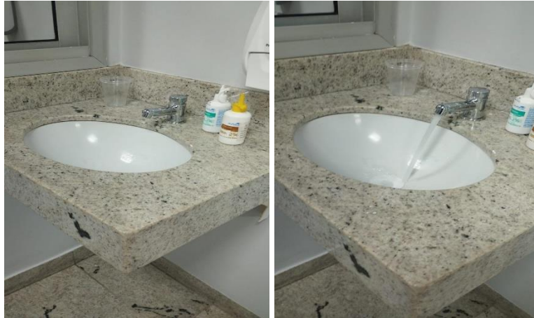
Reativação de alimentação de água.
