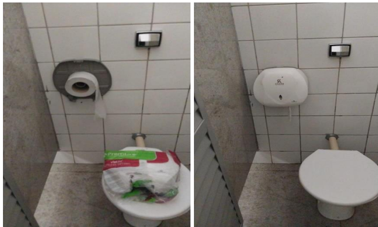
Substituição de dispenser.
