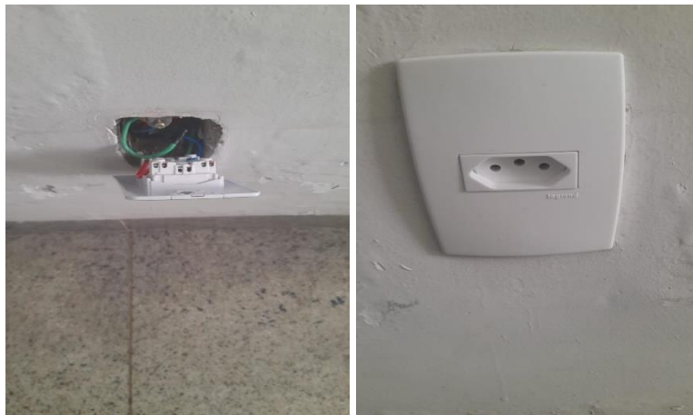
Substituição de tomada
