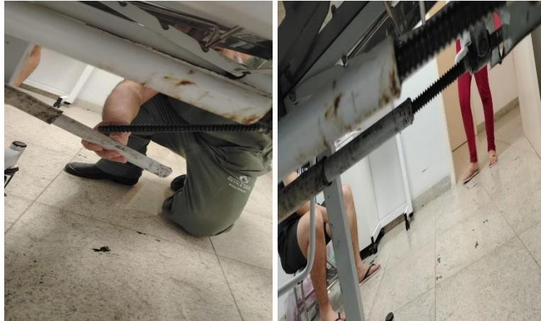
Reparo eixo cama leito.
