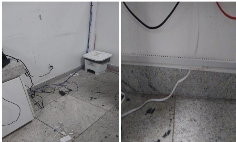
Adequação elétrica NIR
