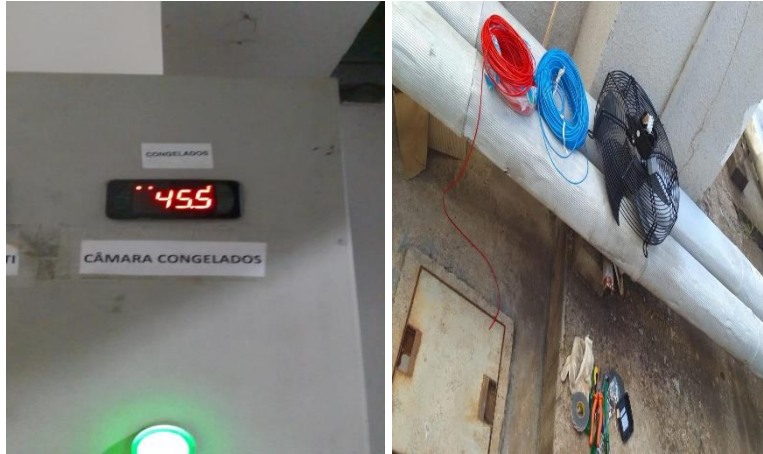
Antes: Substituição de moto ventilador câmara fria.
