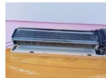
o dreno se encontrava com muito logo devido a sujeira que estava no equipamento
