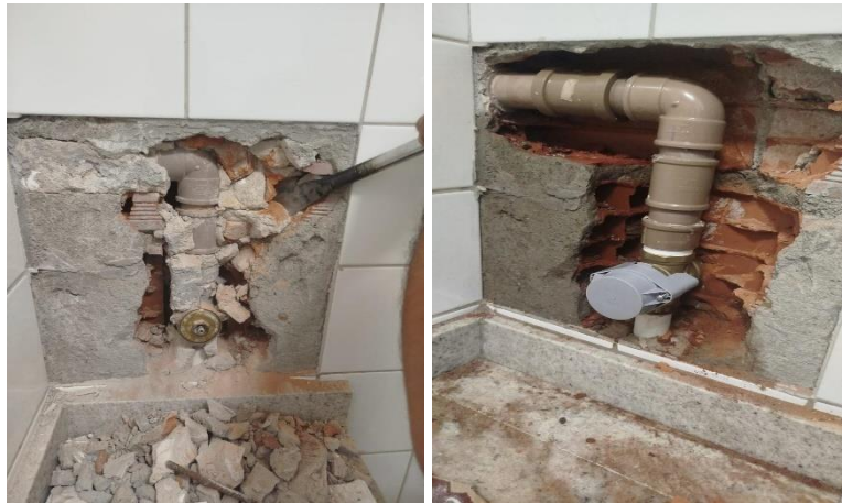
Substituição de válvula de descarga do Expurgo.
