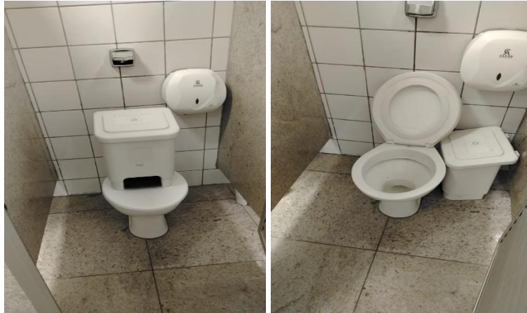
Desobstrução de rede esgoto.
