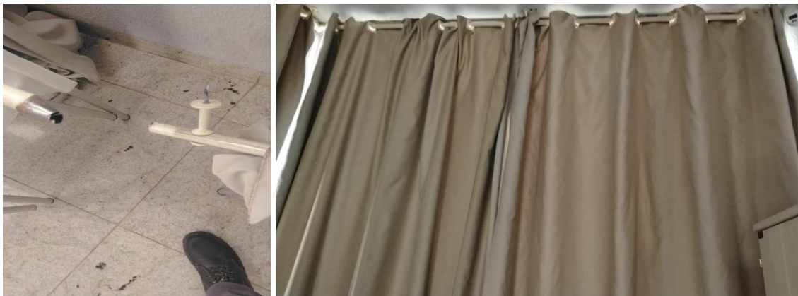
Reparo em cortina Varanda UTIN.
