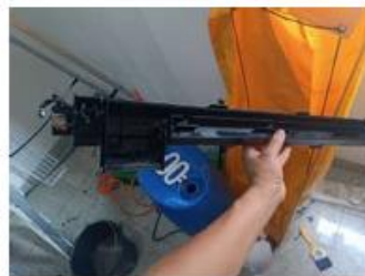
caracol da máquina muito sujo , impedindo o rendimento do equipamento.
