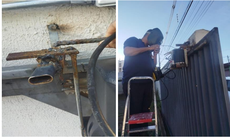
Reparo em solda suporte portão dos gestores.
