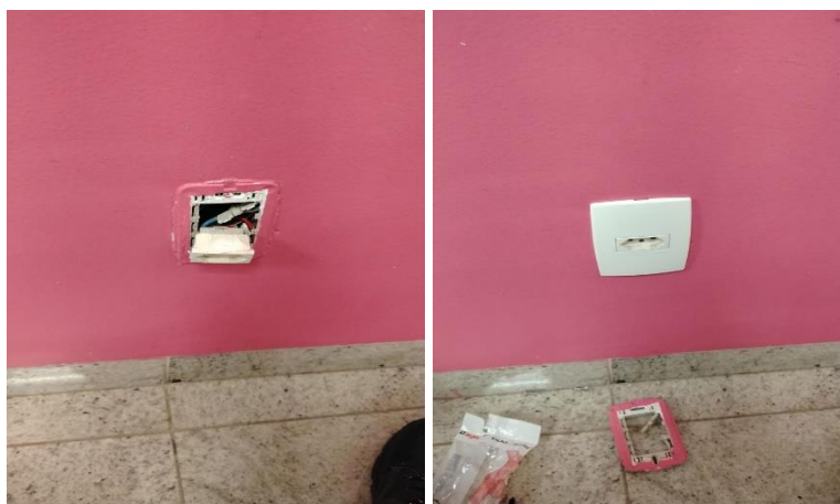
Substituição de tomadas aparentes.
