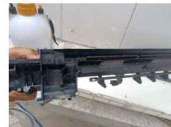
o dreno se encontrava com muito logo devido a sujeira que estava no equipamento
