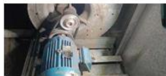
Foi realizado a troca da correia por uma nova , em seguida foi realizado a regulagem do motor .
