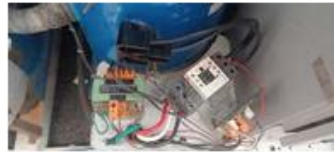
Fotos depois da manutenção corretiva do comando do compressor 02 circuito A
