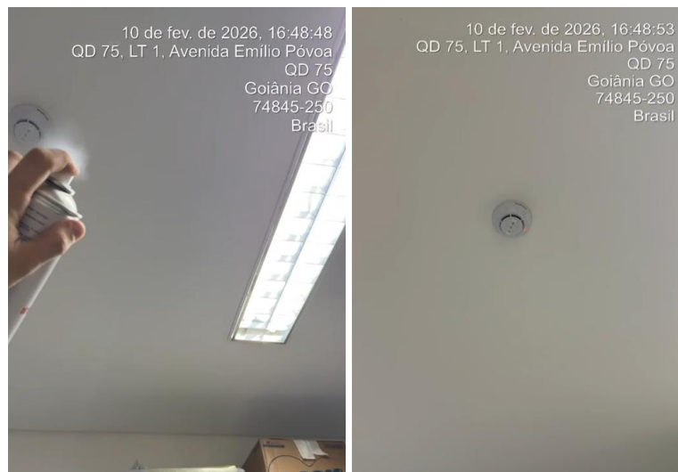
Realização de teste dos sensores de fumaça.
