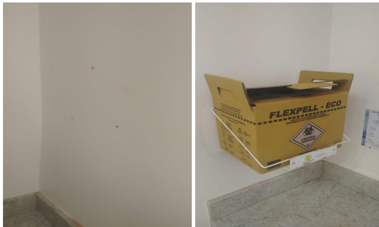
Instalação de caixa perfuro cortantes.
