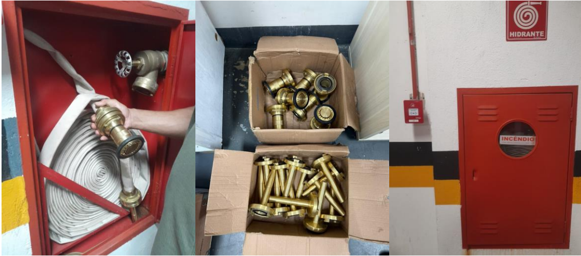
Readequações das caixas de hidrantes.
