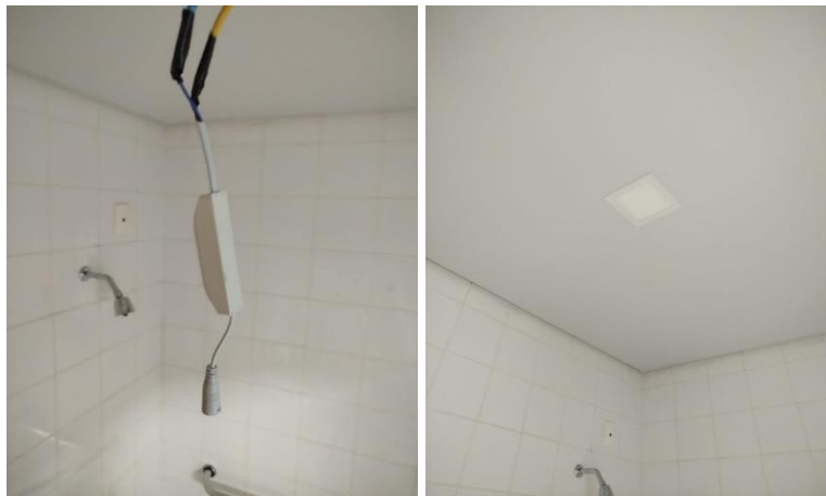
Substituição de luminária.
