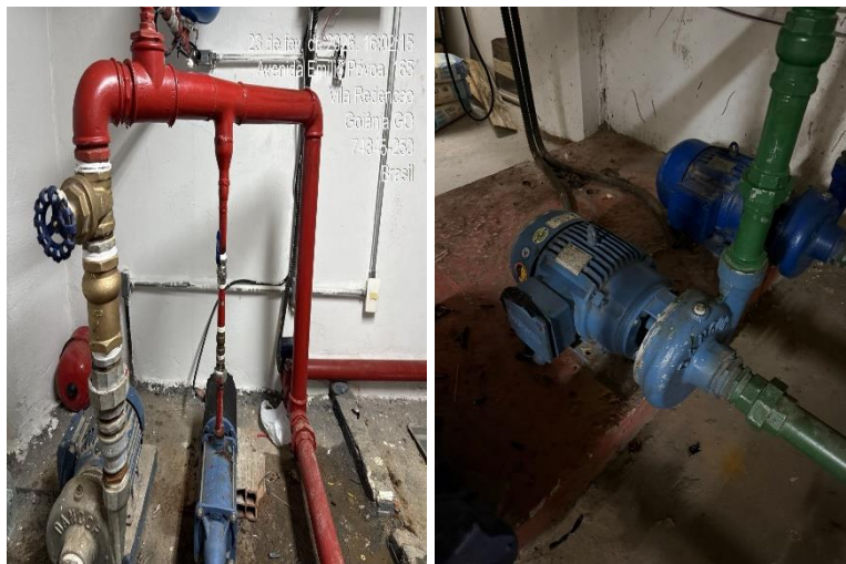
Depois: Bombas reinstaladas e operando.
