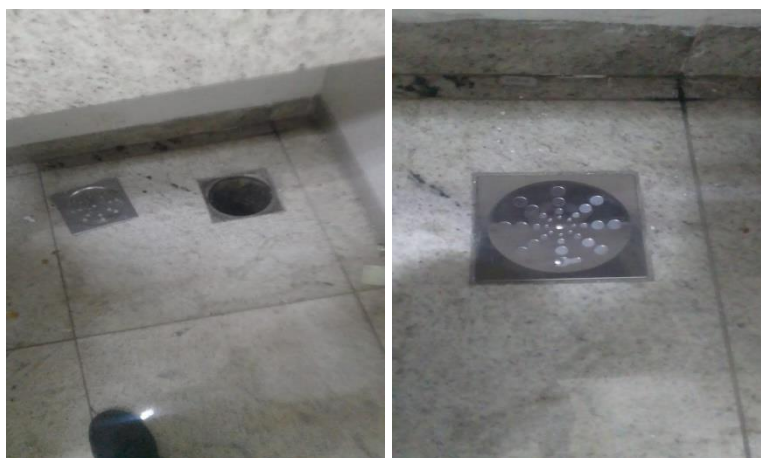
Substituição de acabamentos para ralo.
