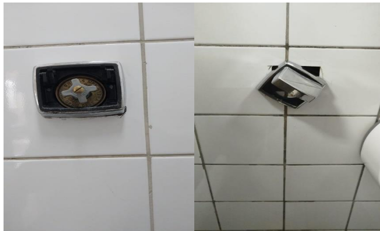
Antes: Acabamentos de válvula de descarga danificados.
