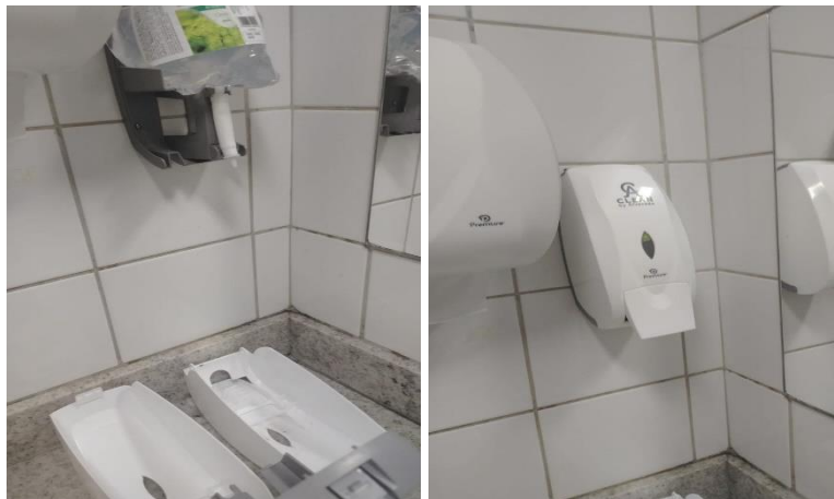
Substituição de dispenser.
