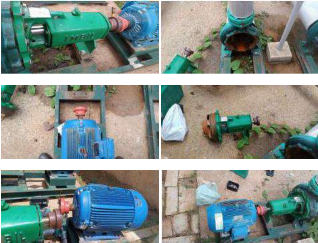
Retifica de bomba do chiller e reinstalação.
