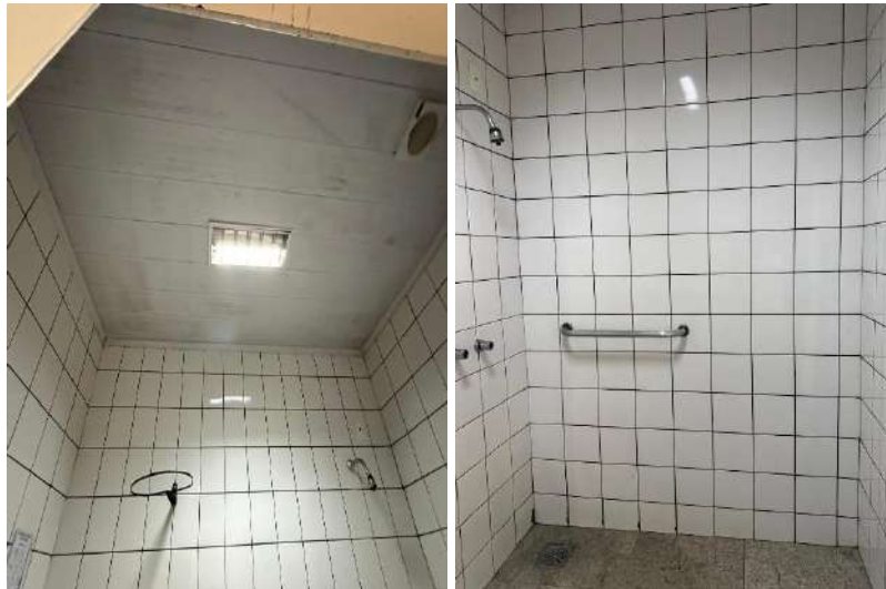
Antes (banheiro da suíte PPP 05)
