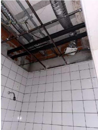
Durante (Remoção do Forro PVC e Gesso Plaquinha)
