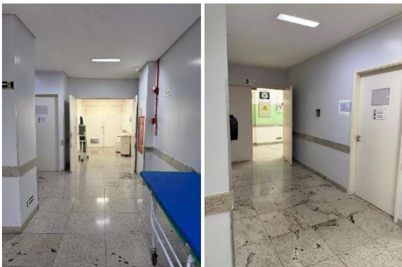
Depois (Pintura em Andamento dos Setores.)
