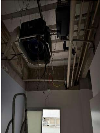
Durante (Remoção do Forro PVC e Gesso Plaquinha)
