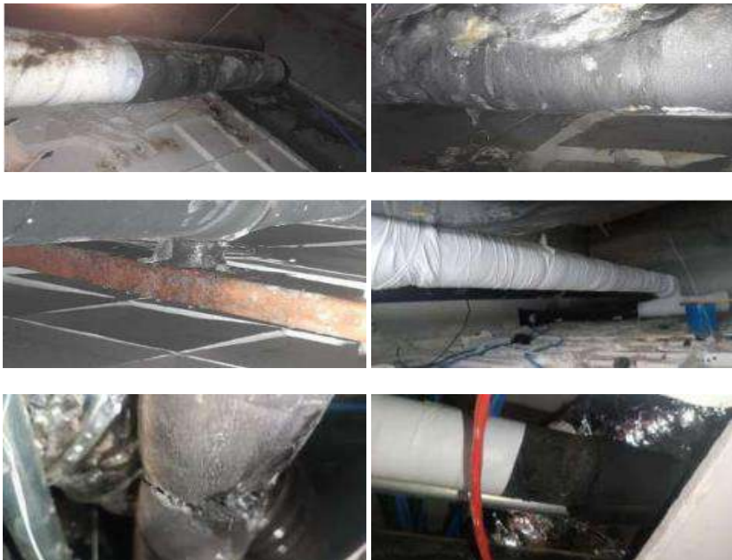
Reparo em tubulação do chiller.
