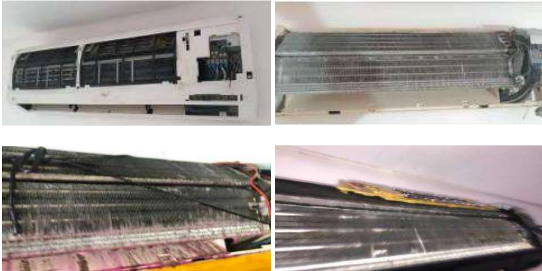
Depois (Serviços de limpeza e higienização.)
