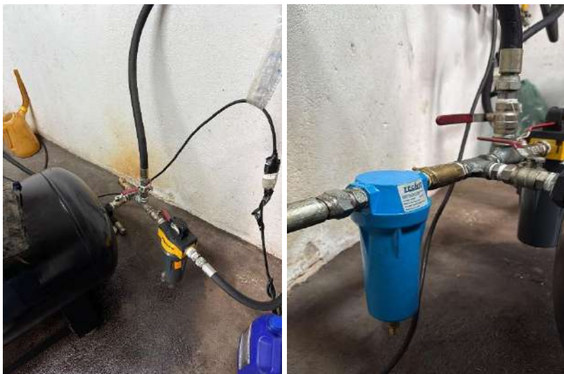
Substituição de filtro saturado (esquerda) para filtro novo (Direita)
