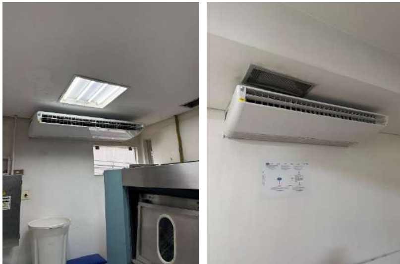
Instalação dos equipamentos na lavanderia.
