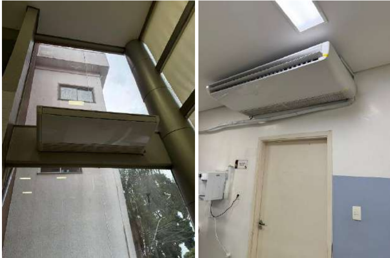
Instalação dos equipamentos na recepção
