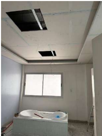
Durante (Instalação de forro em drywall com sanca)
