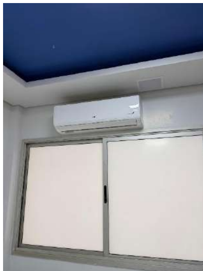
Instalação do ar suite PPP05.
