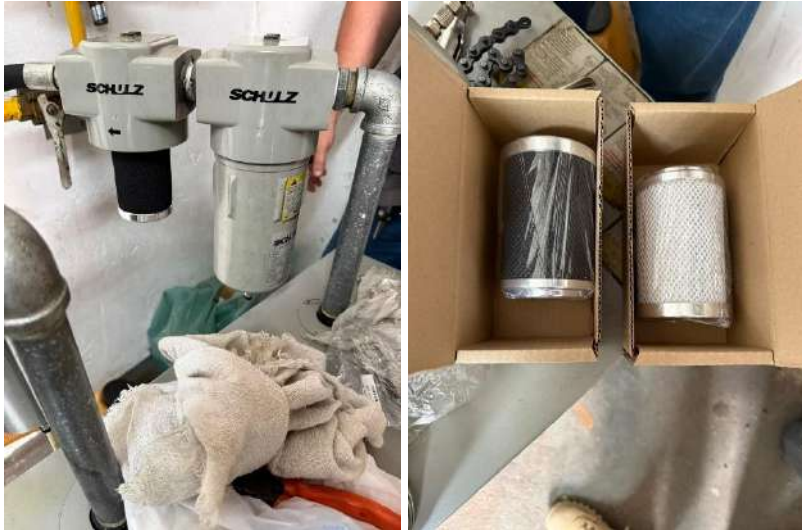
Substituição dos filtros coalescentes existentes
