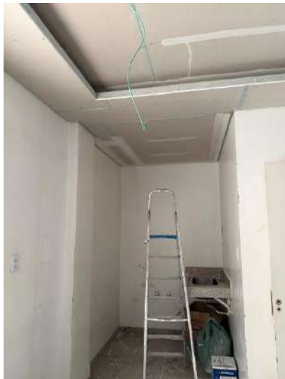
Durante (Instalação de forro em drywall com sanca)
