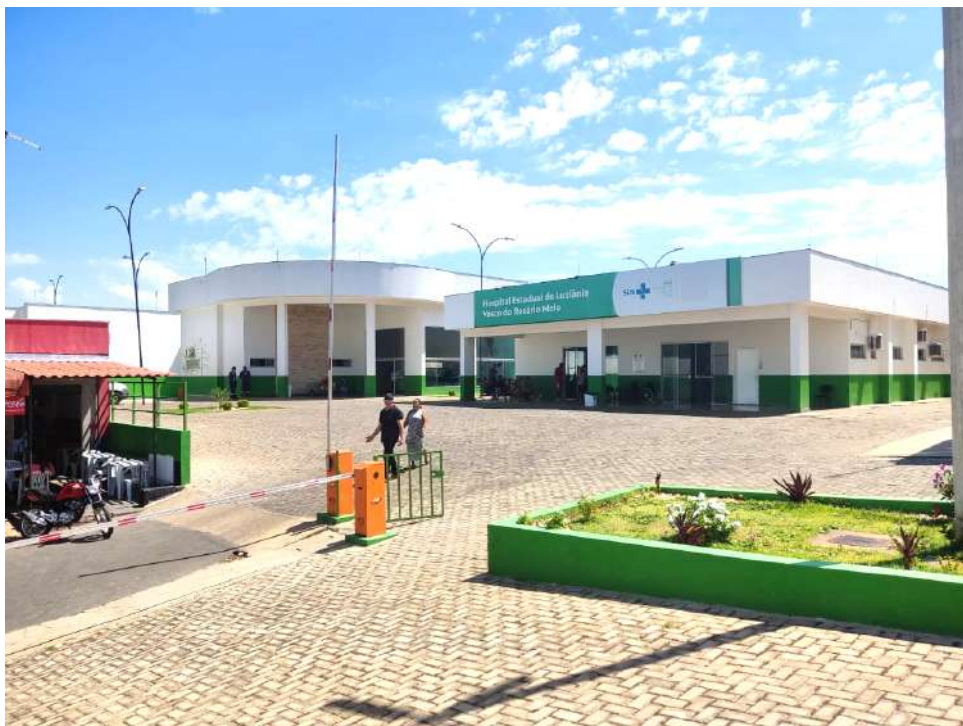
Figura 2. Fachada frontal atual Fonte: Autor.
