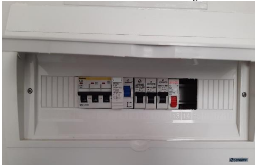
Novo circuito elétrico das salas cirúrgicas
