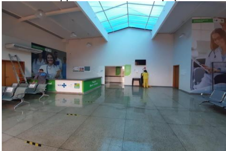
Recepção Central antes das adequações
