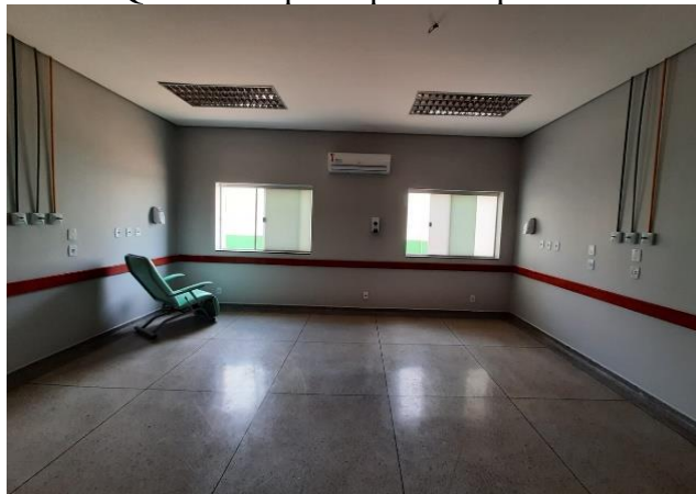
Quarto 03 após reparos de pintura
