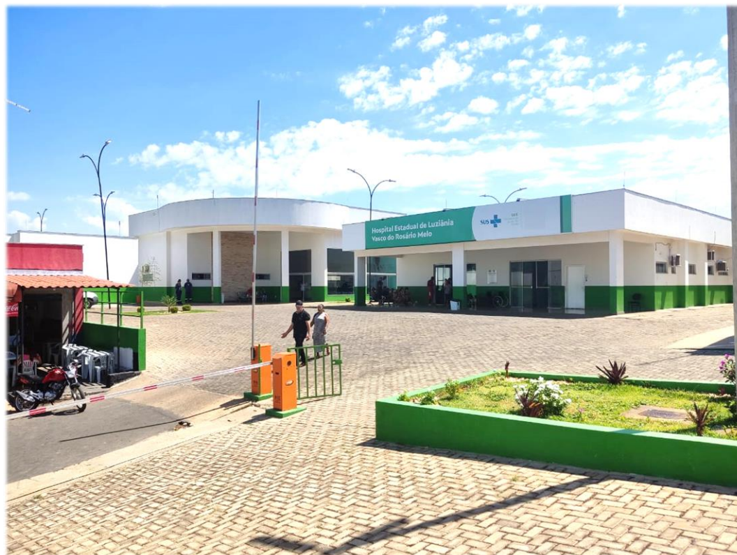
Figura 2. Fachada frontal atual Fonte: Autor.
