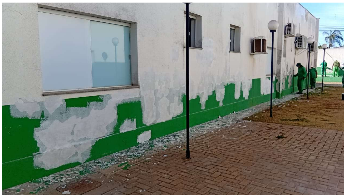
Revitalização de pintura externa: Jardim interno
