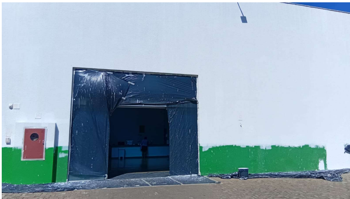
Revitalização de pintura externa: Fachada recepção central
