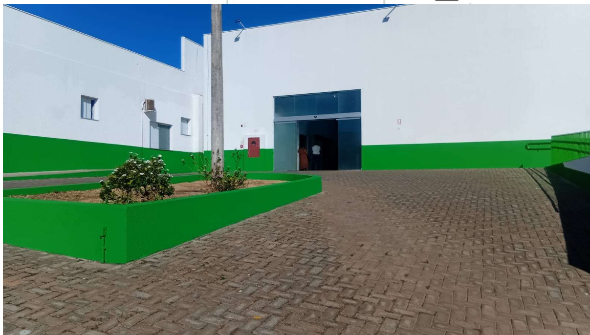
Revitalização de pintura externa: Fachada recepção central
