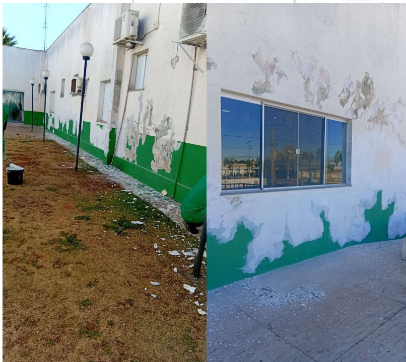
Revitalização de pintura externa: Jardim interno
