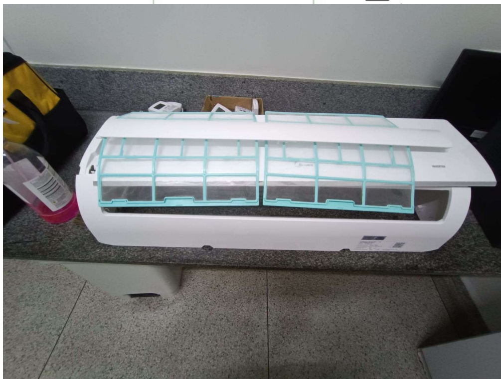
Manutenção preventiva em equipamentos de ar condicionado
