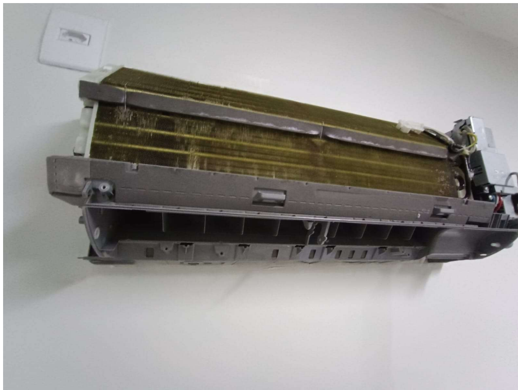
Manutenção preventiva em equipamentos de ar condicionado
