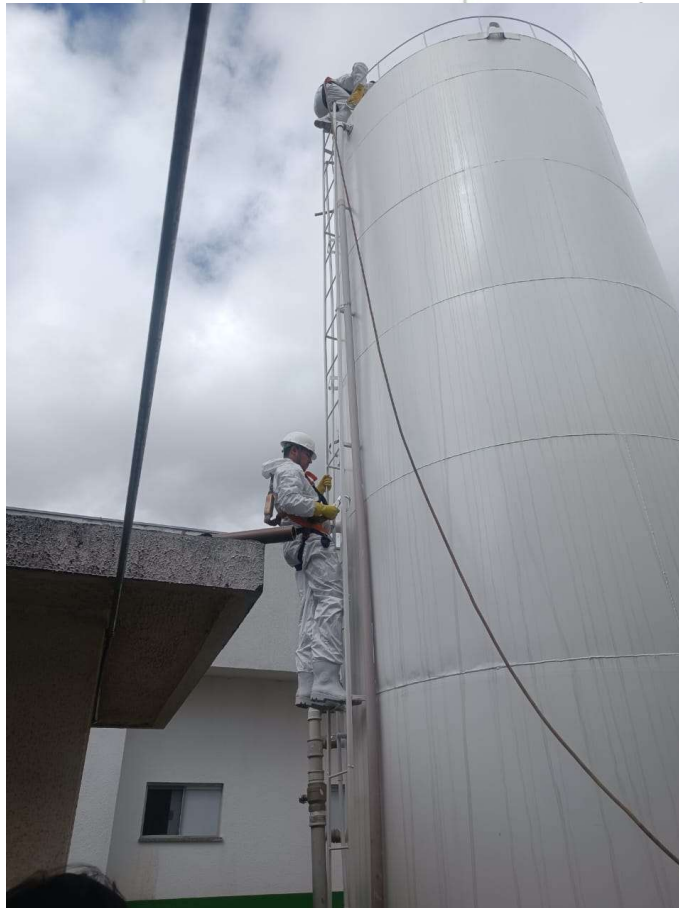
Limpeza dos reservatórios de água
