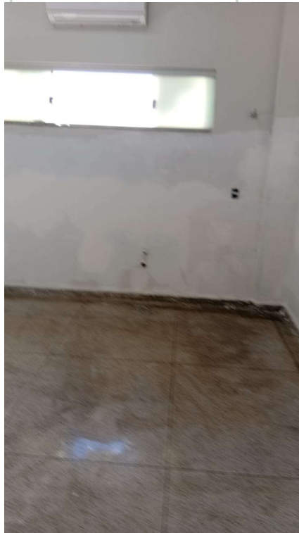
Pintura interna da sala de internação
