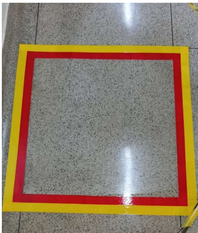
Revitalização de demarcações de piso de SPCI
