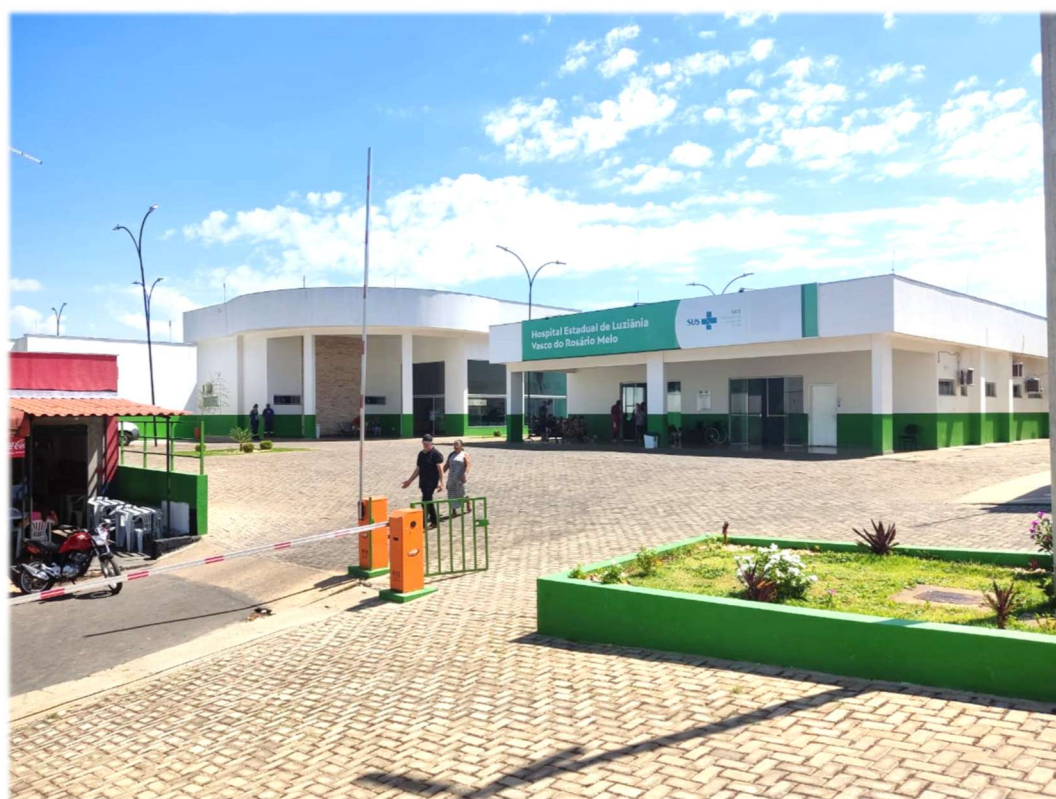
Figura 2. Fachada frontal atual
