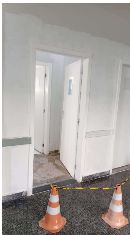
Pintura interna da sala de internação
