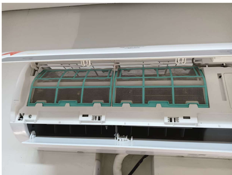
Manutenção preventiva em equipamentos de ar condicionado
