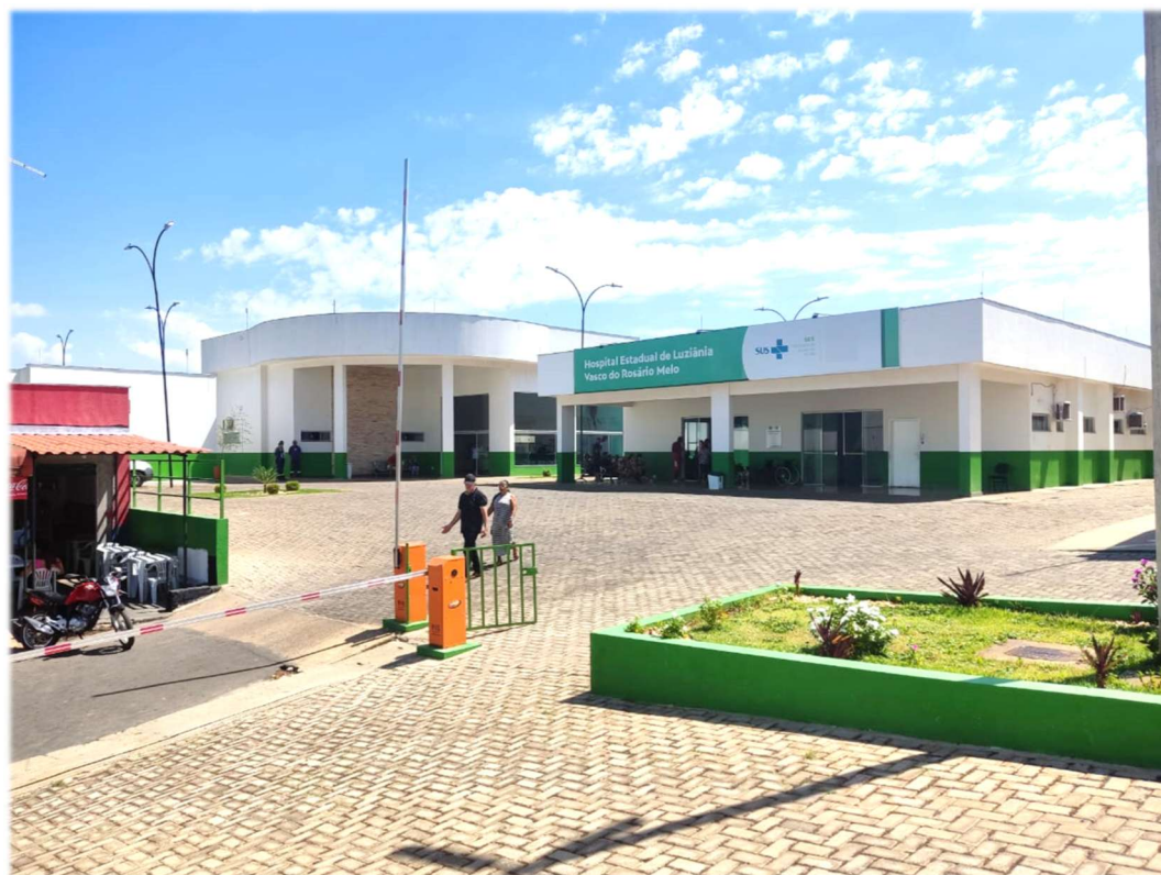
Figura 2. Fachada frontal atual
