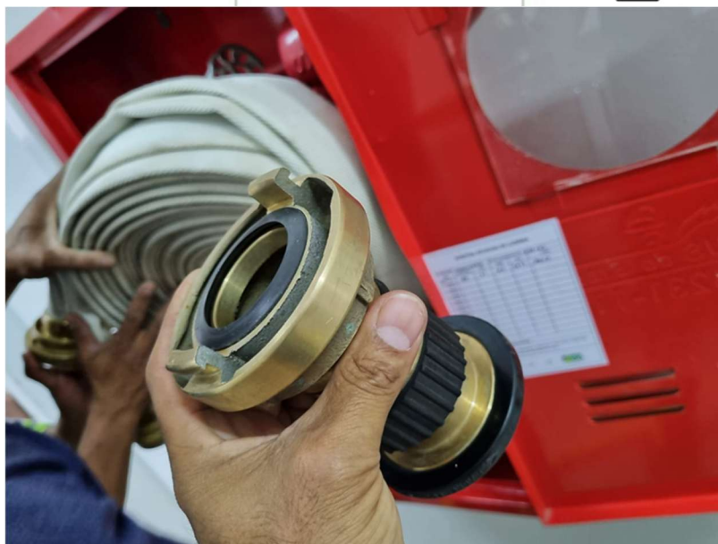
Verificação de caixas de hidrantes
