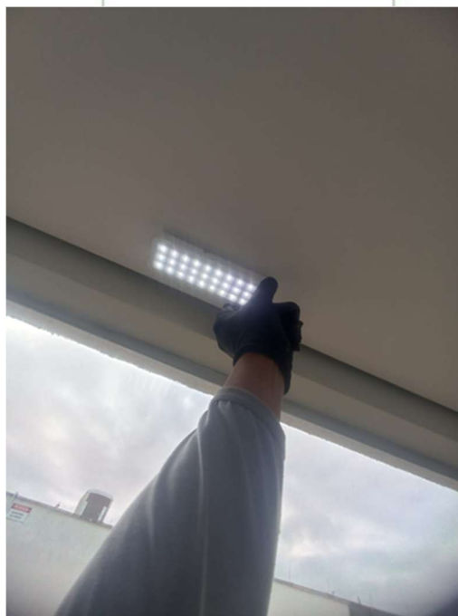
Manutenção preventiva luminárias de emergência
