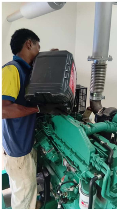
Manutenção preventiva de grupos geradores
