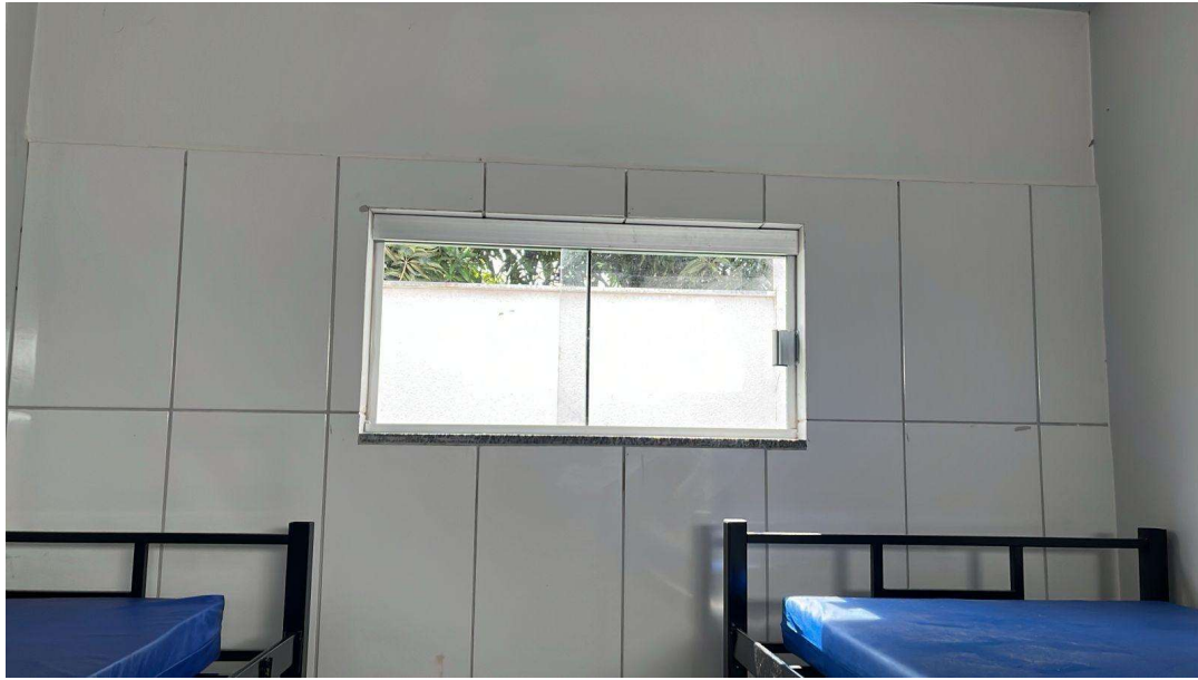
Instalação de janelas no repouso masculino
