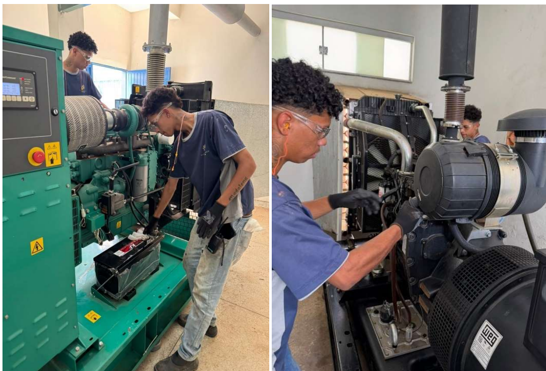
Manutenção preventiva grupos geradores
