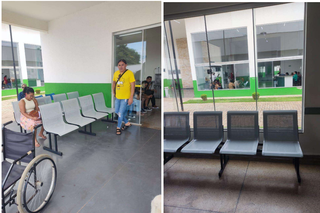
Reparo longarinas do pronto socorro
