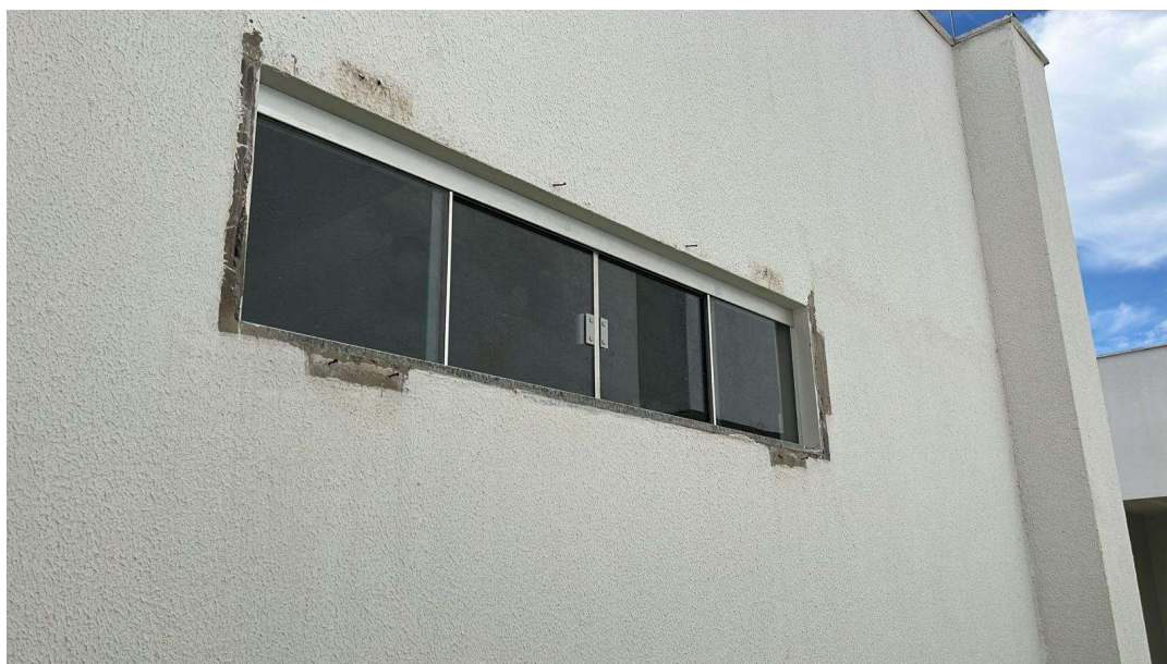
Instalação de janelas no repouso masculino
