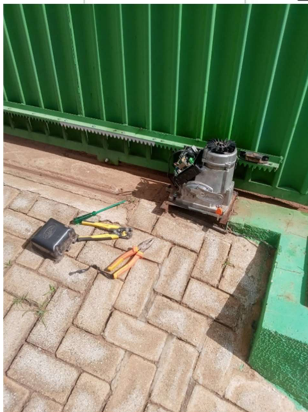
Reparo motor do portão de carga e descarga
