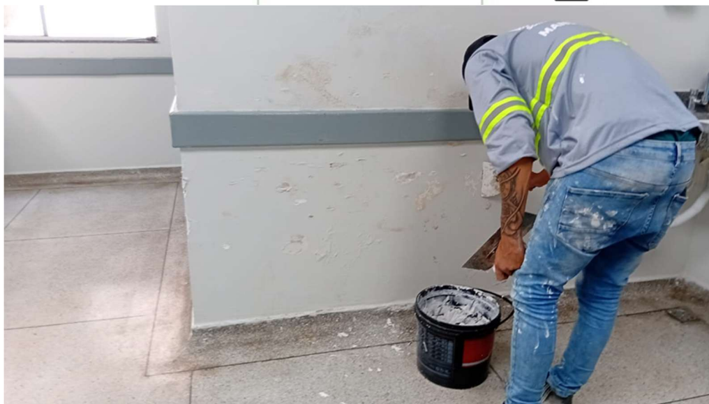
Reparo de pintura interna de enfermarias e áreas comuns
