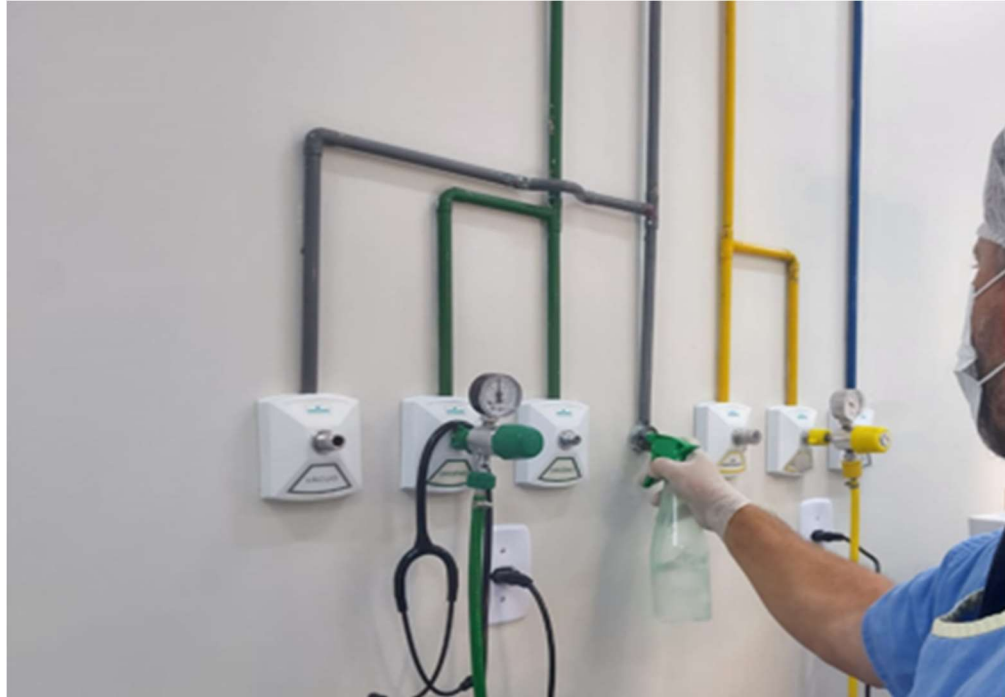
Manutenção preventiva em rede de gases medicinais
