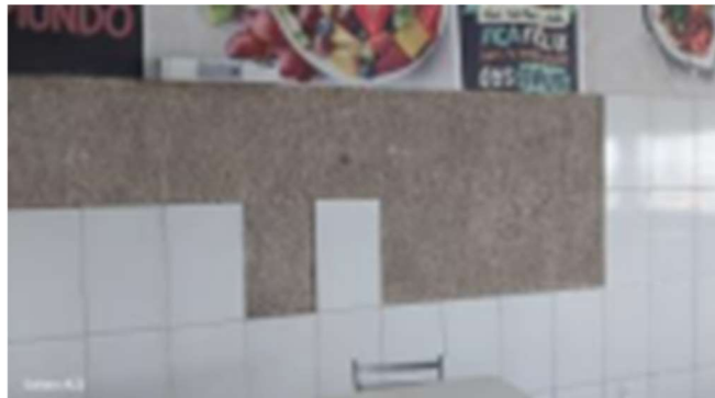
Manutenção preventiva em revestimento cerâmico do refeitório
