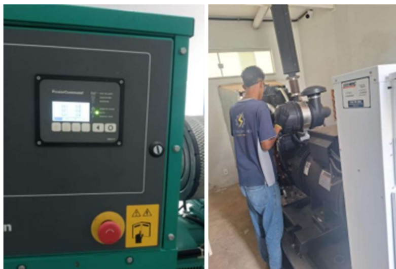
Manutenção preventiva de grupos geradores
