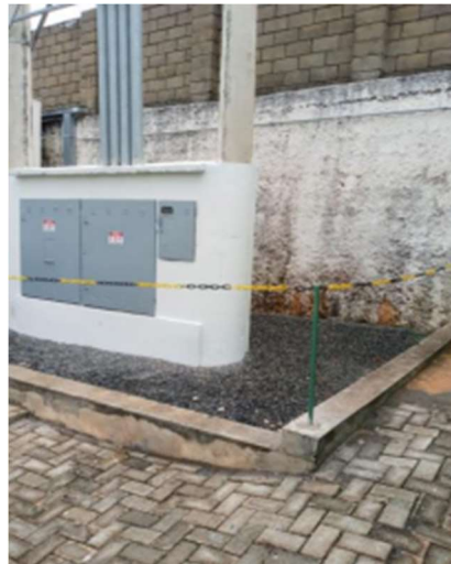
Revitalização de pintura e cercamento da subestação
