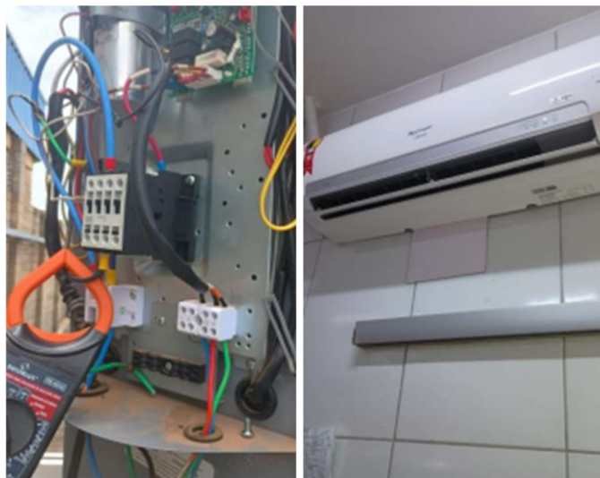
Manutenção corretiva e preventiva em equipamentos de ar condicionado
