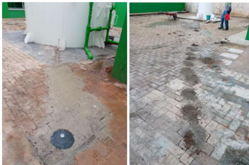
Aterramento de reservatórios de água para adequação do sistema de SPDA
