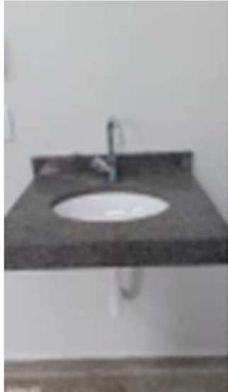
Instalação de lavatório na sala e RPA da Endoscopia
