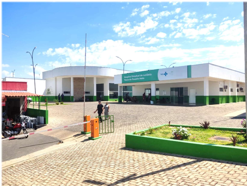
Figura 2. Fachada frontal atual Fonte: Autor.
