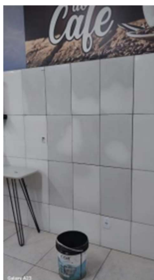
Manutenção preventiva em revestimento cerâmico do refeitório
