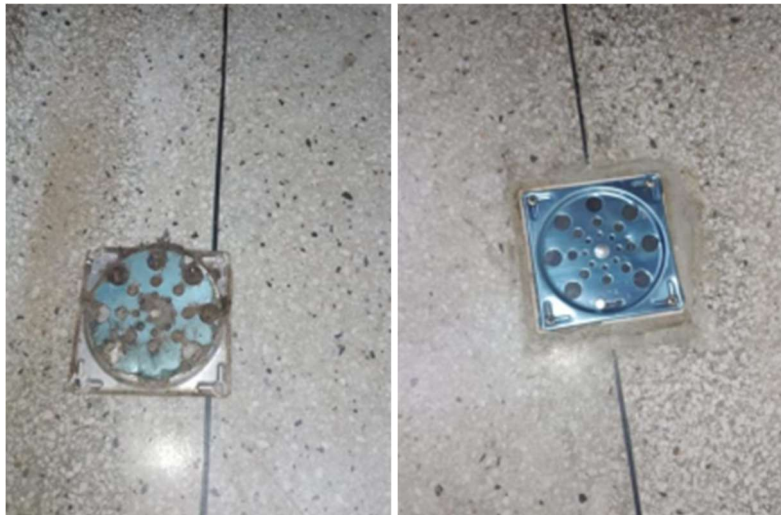
Substituição de ralos
