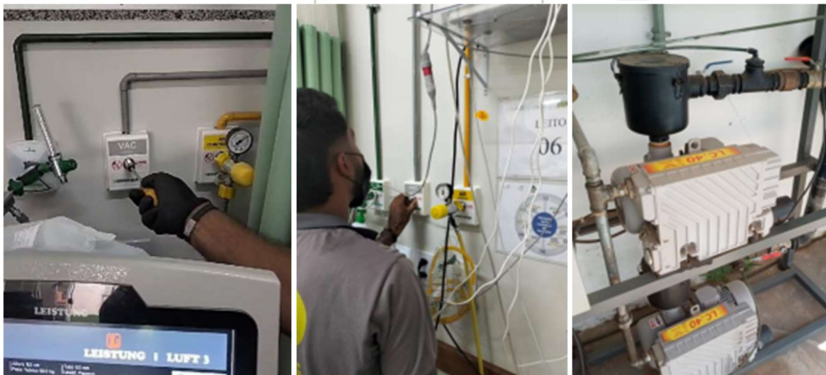
Manutenção preventiva em sistema de gases medicinais
