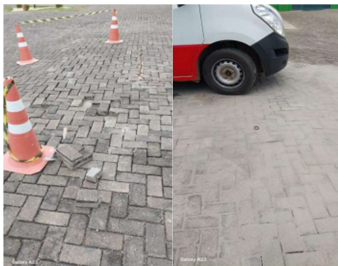
Reparo de piso externo intertravado
