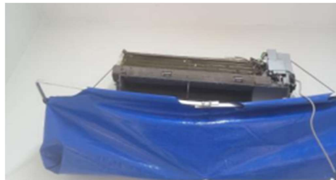
Manutenções preventivas em equipamentos de ar condicionado
