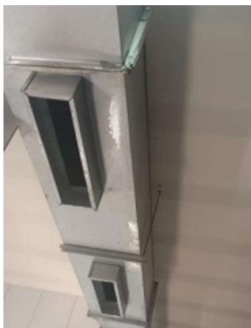
Manutenção preventiva sistema de exaustão/ventilação cozinha
