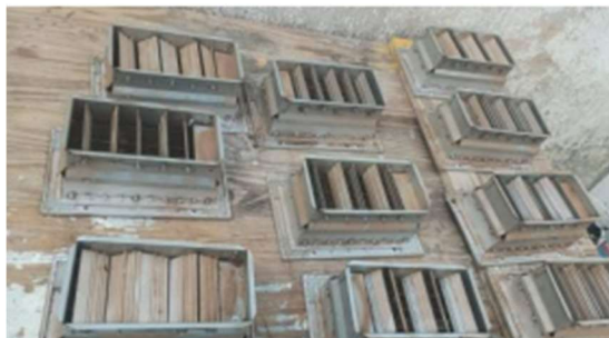
Manutenção preventiva sistema de exaustão/ventilação cozinha
