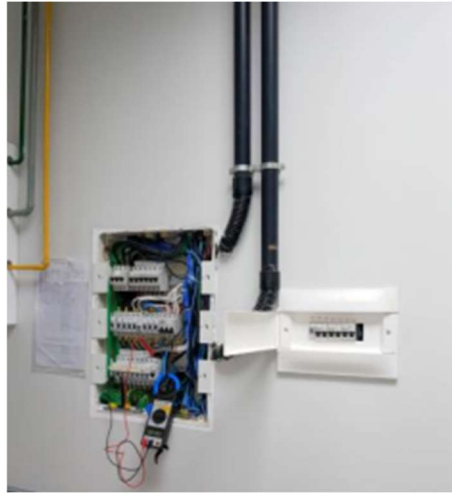
Manutenção preventiva dos circuitos e quadros elétricos
