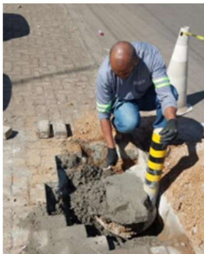
Manutenção corretiva piso estacionamento externo
