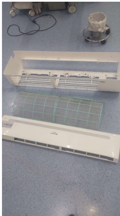
Manutenção preventiva de ar-condicionado
