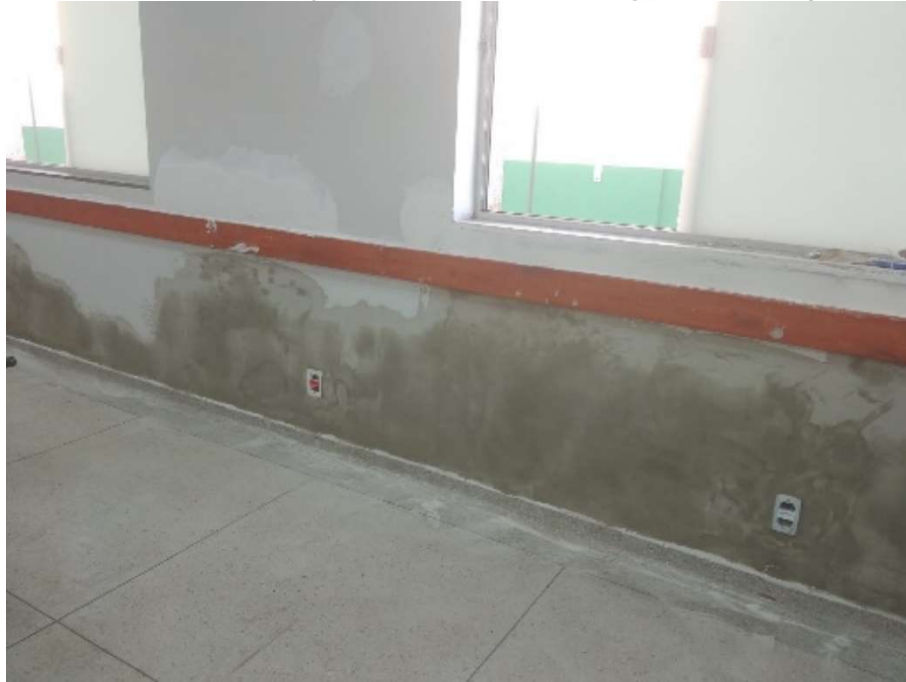
Serviço de revitalização dos quartos de enfermaria
