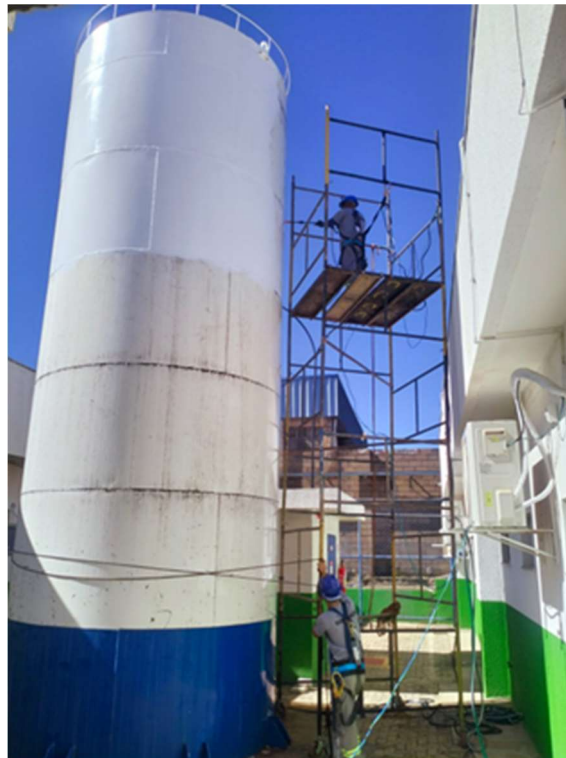
Revitalização de pintura de reservatório de água
