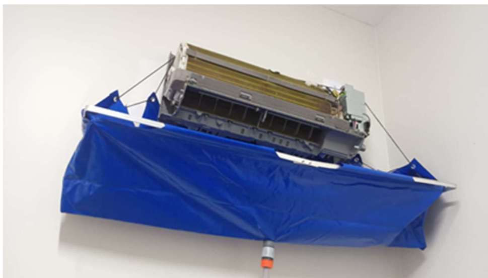
Manutenção preventiva de ar condicionado
