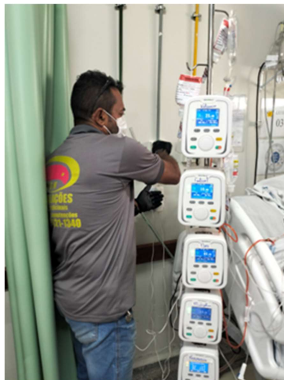
Manutenção preventiva em rede de gases medicinais
