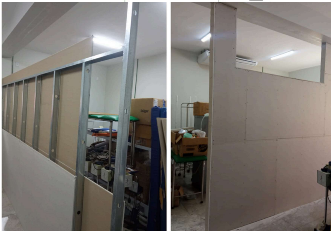
Adequação de sala de engenharia clínica
