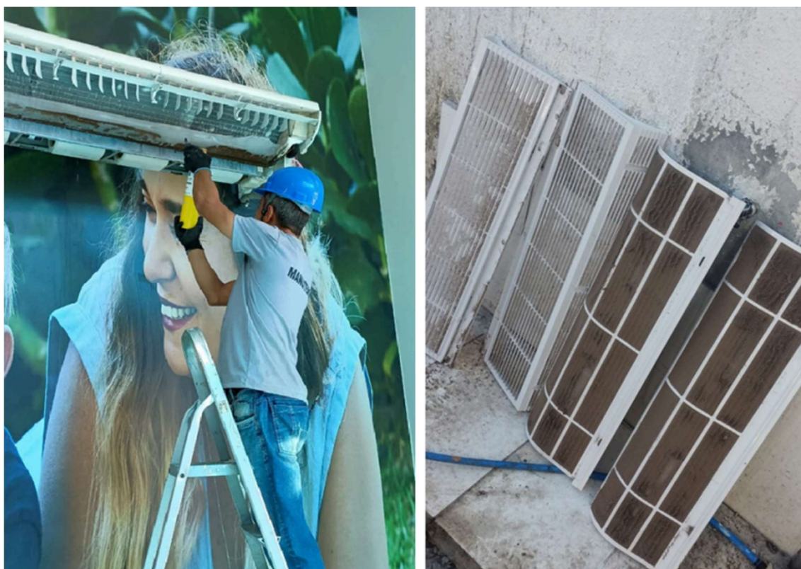
Manutenções preventivas e corretivas em equipamentos de ar condicionado
