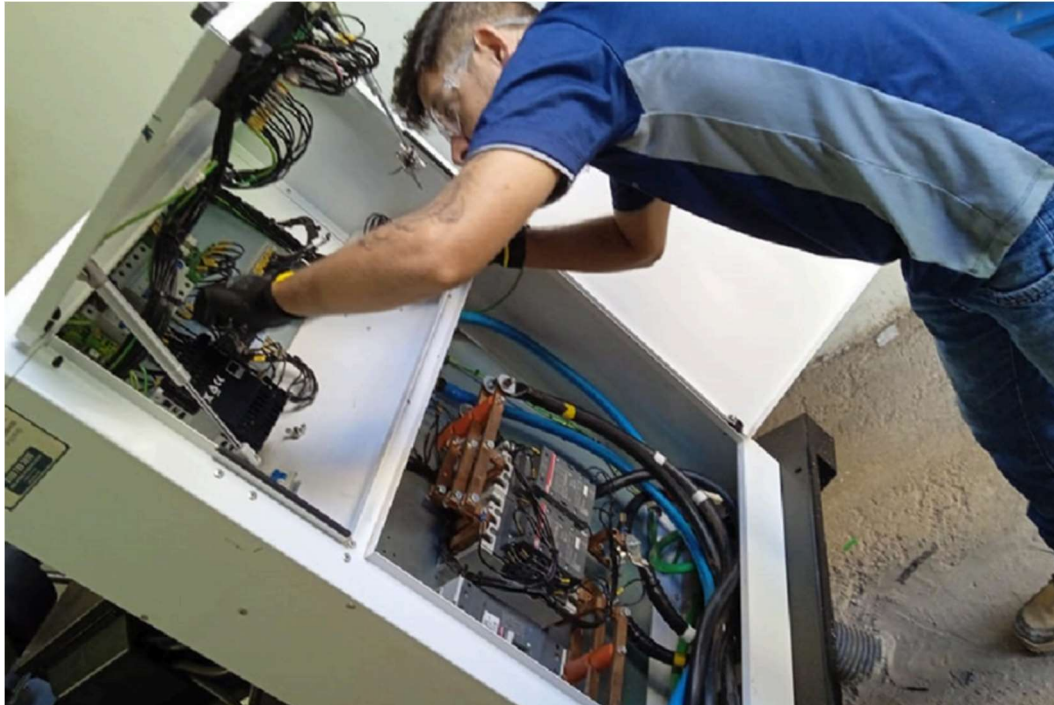
Manutenção preventiva dos grupos geradores
