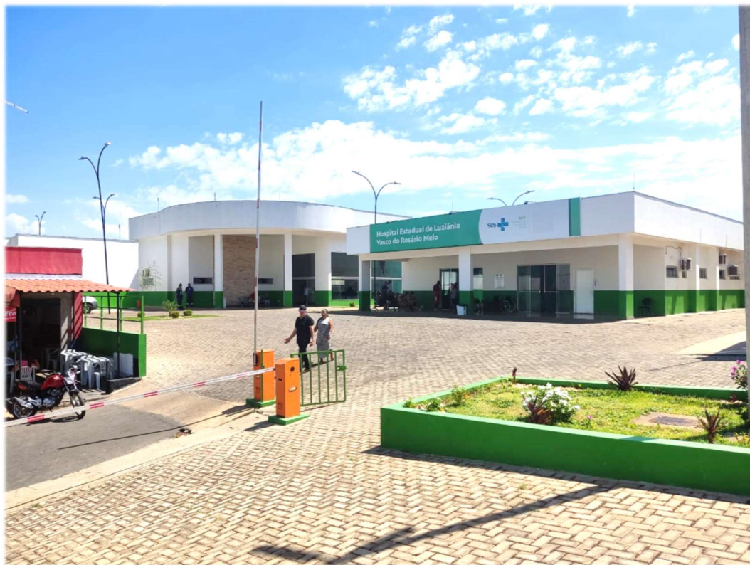
Figura 2. Fachada frontal atual Fonte: Autor.
