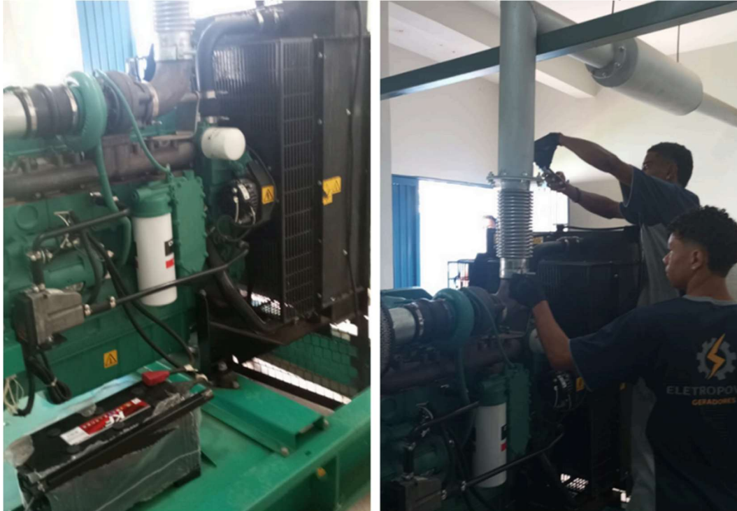
Manutenção preventiva dos grupos geradores
