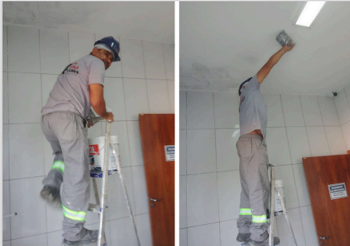
Reparo de pintura teto cozinha
