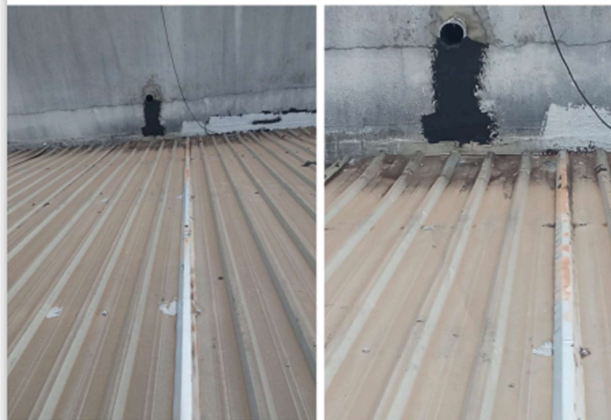
Reparo de cobertura
