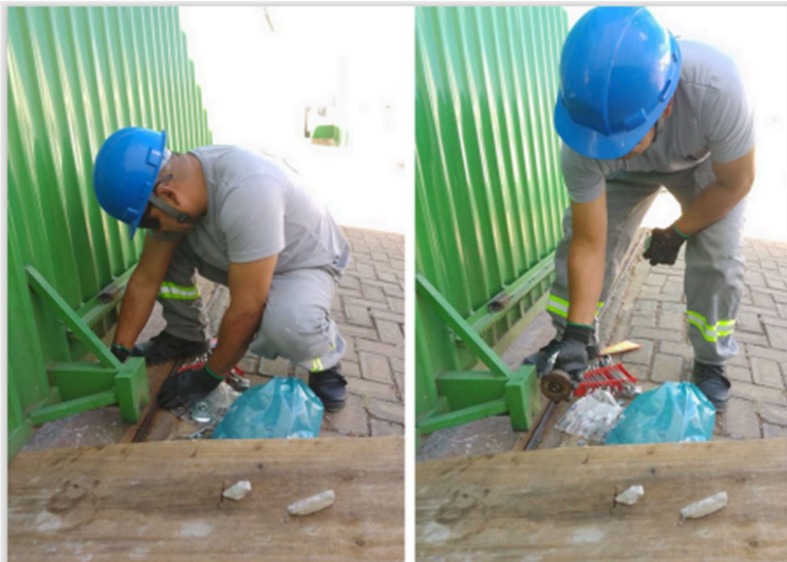
Substituição de roldanas do portão de carga e descarga
