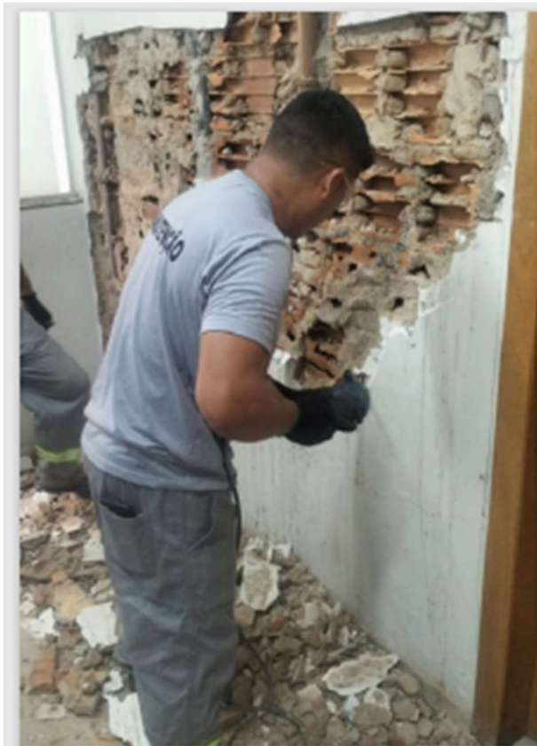
Retirada de vazamento em tubulação de água da sala de Qualidade e CCIH
