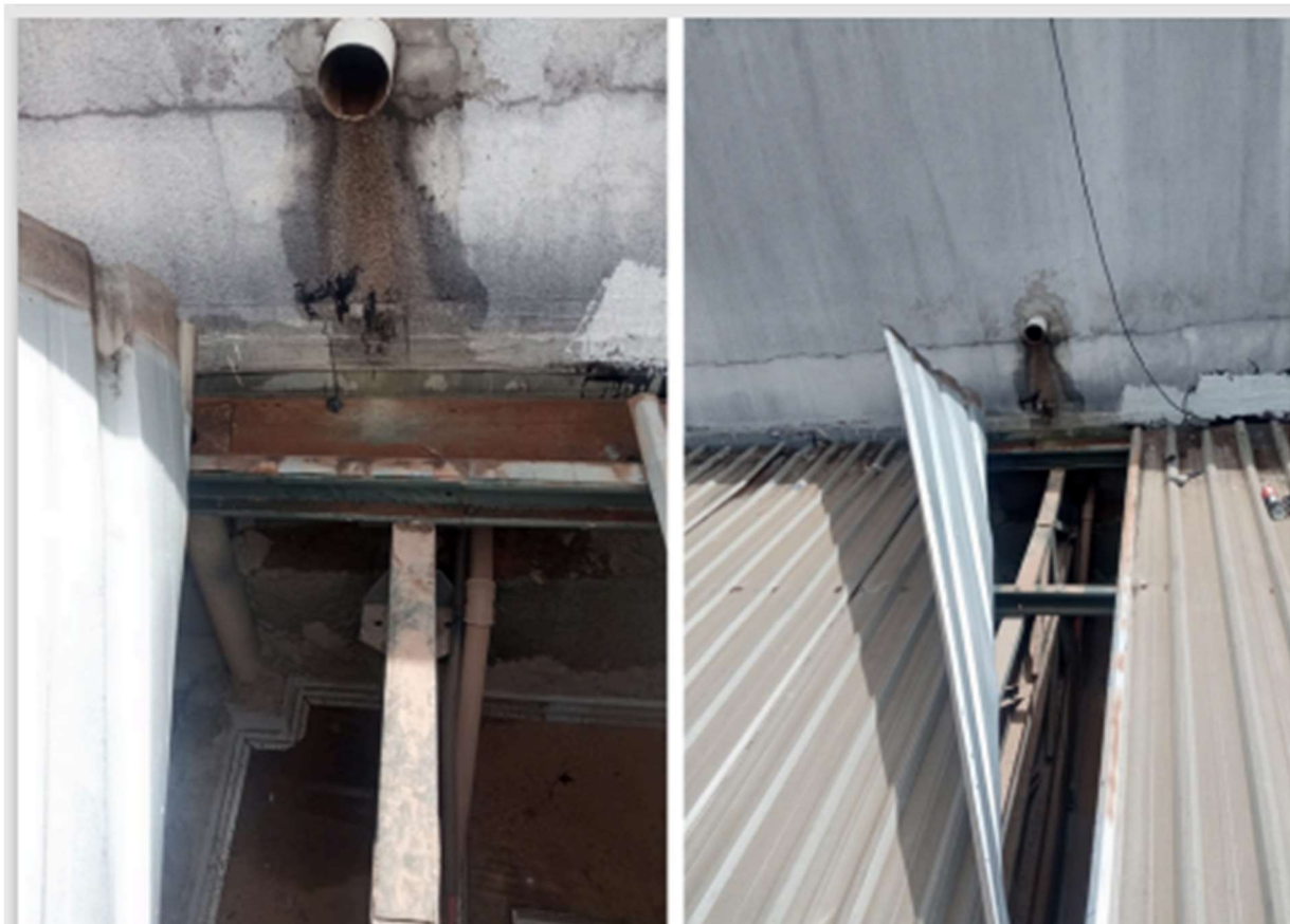
Reparo de cobertura
