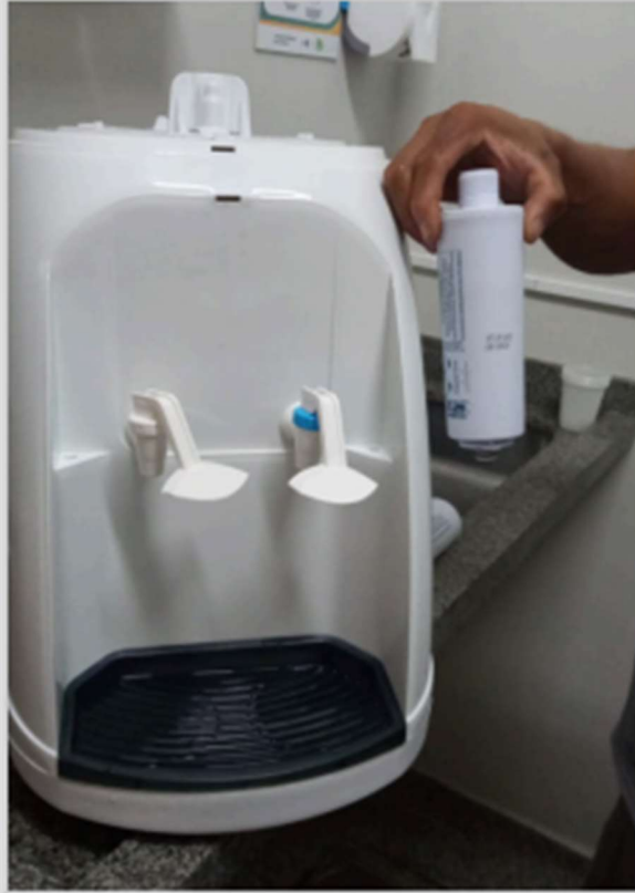
Substituição de filtros de bebedouros
