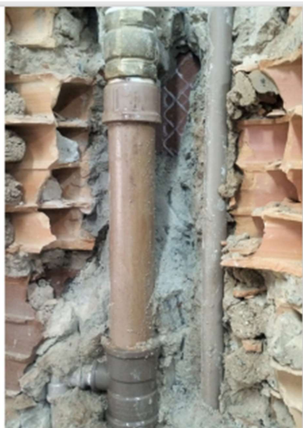
Retirada de vazamento em tubulação de água da sala de Qualidade e CCIH
