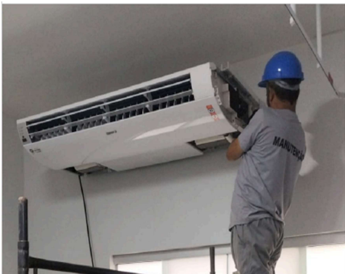
Instalação de novos equipamentos de ar condicionado
