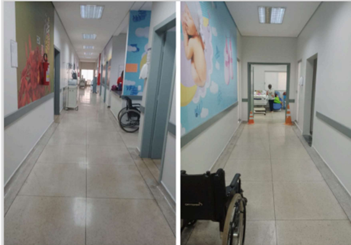
Revitalização de pintura nos corredores das enfermarias
