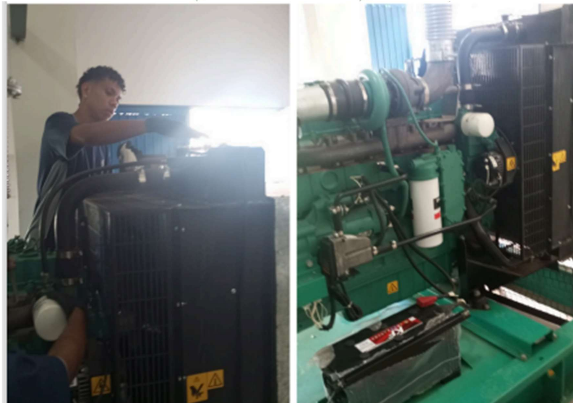
Manutenção preventiva de grupos geradores
